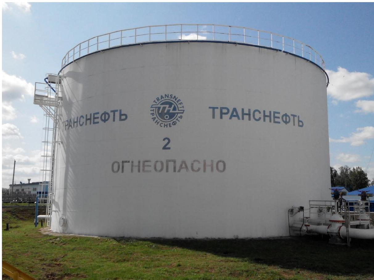
Рисунок 1 - Общий вид резервуаров вертикальных стальных цилиндрических РВСП-5000
