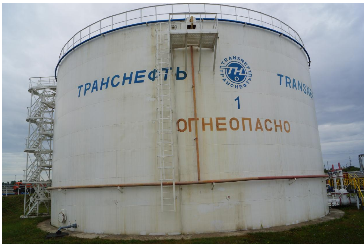
Рисунок 2 - Общий вид резервуаров вертикальных стальных цилиндрических РВСП-5000
