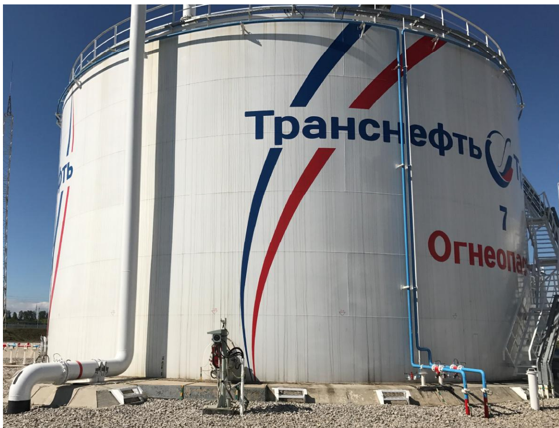
Рисунок 1 - Общий вид резервуаров вертикальных стальных цилиндрических РВС-5000
