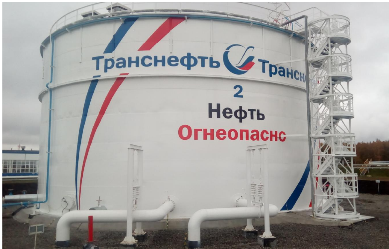
Рисунок 1 - Общий вид резервуара вертикального стального цилиндрического РВС-5000
