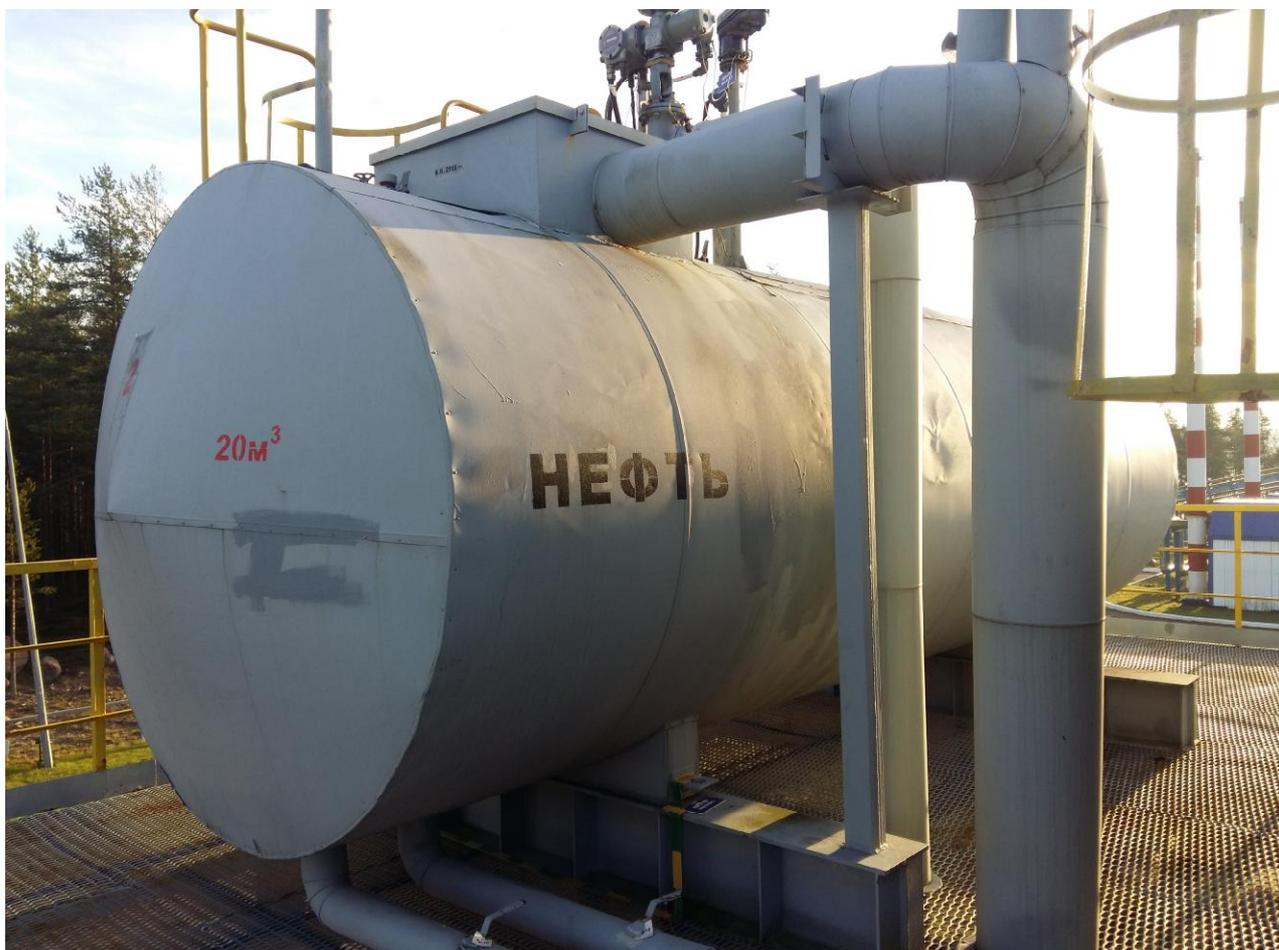
Рисунок 1 - Общий вид резервуара РГС-20
