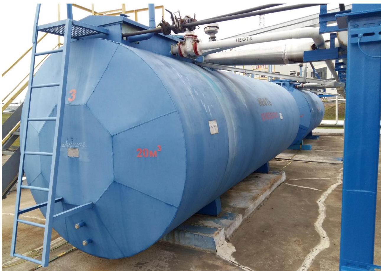
Рисунок 1 - Общий вид резервуара РГС-20
