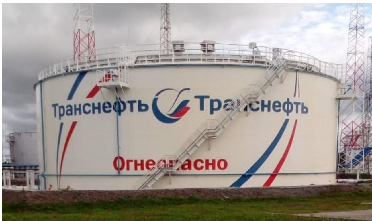
Рисунок 1 - Общий вид резервуаров вертикальных стальных цилиндрических РВС-10000
