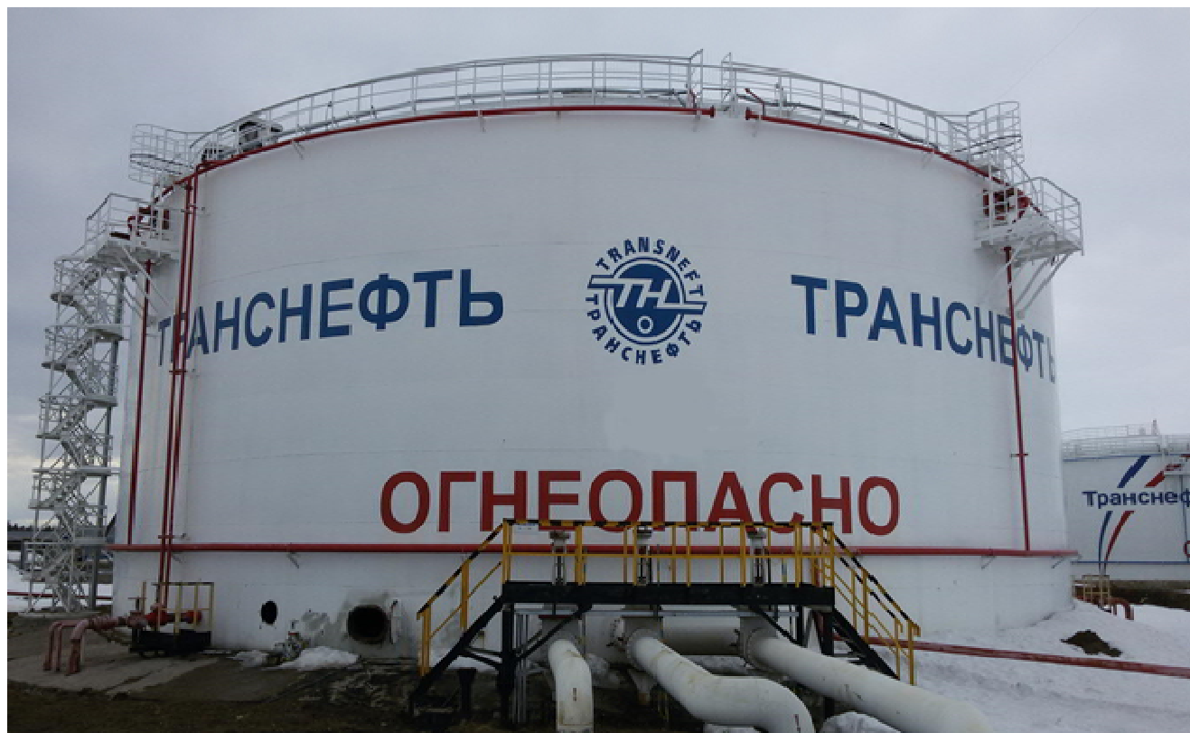
Рисунок 3 - Общий вид резервуаров вертикальных стальных цилиндрических РВСП-75000
