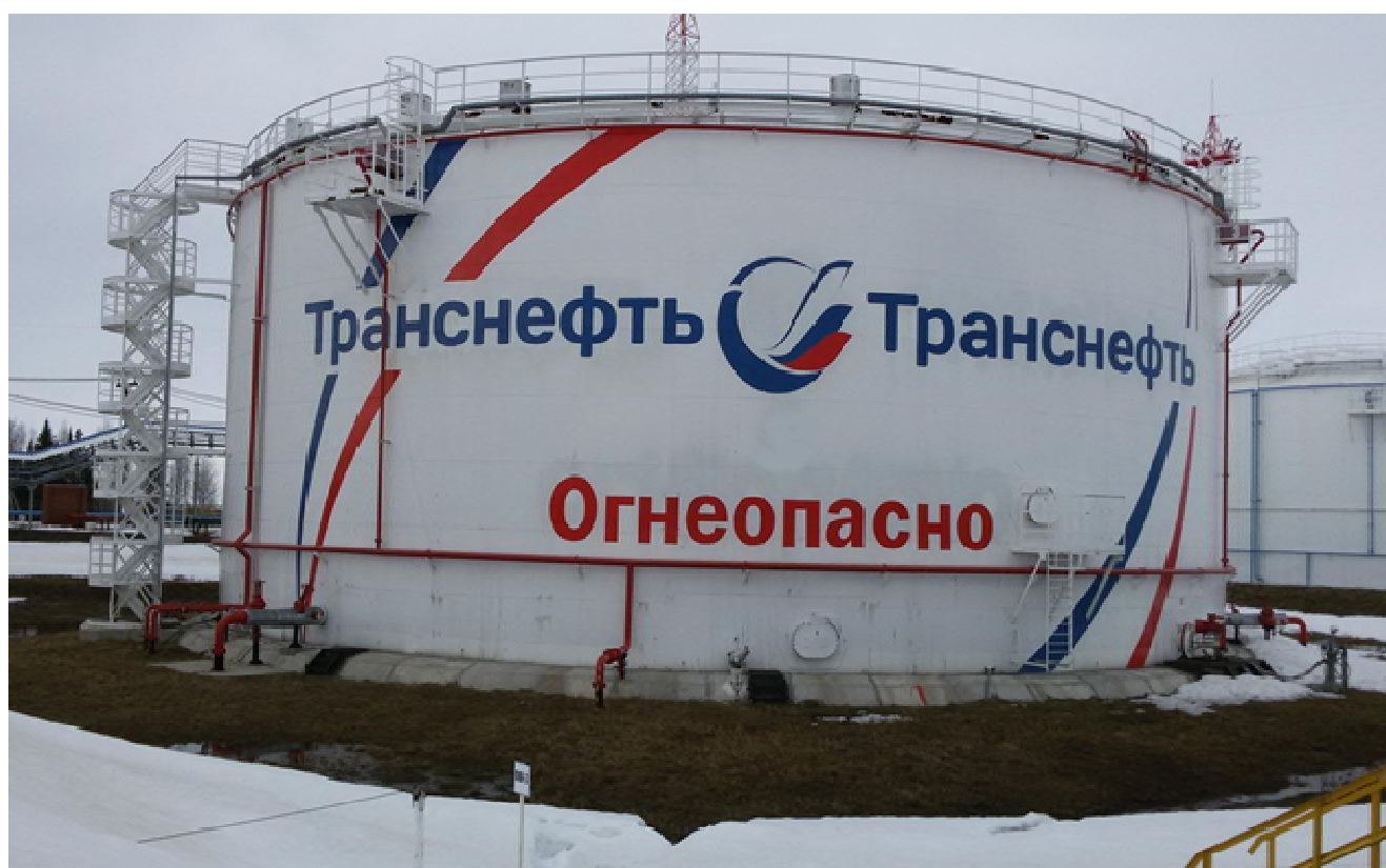
Рисунок 2 - Общий вид резервуаров вертикальных стальных цилиндрических РВСП-5000
