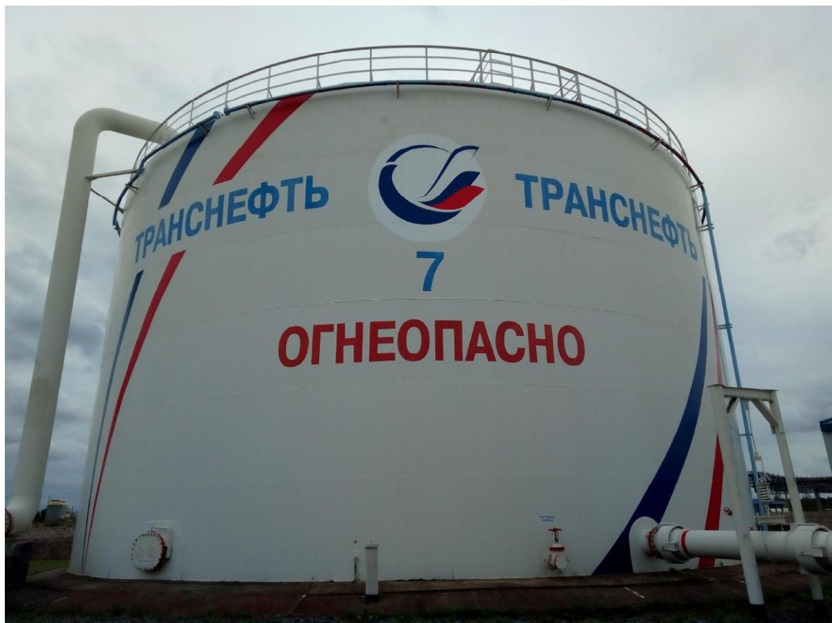
Рисунок 1 - Общий вид резервуара вертикального стального цилиндрического РВС-5000
