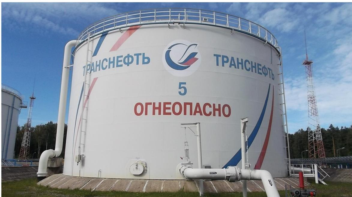
Рисунок 1 - Общий вид резервуара вертикального стального цилиндрического РВС-5000
