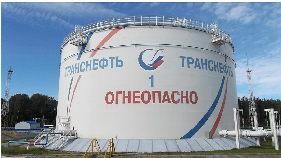
Рисунок 2 - Общий вид резервуара вертикального стального цилиндрического РВСП-20000
