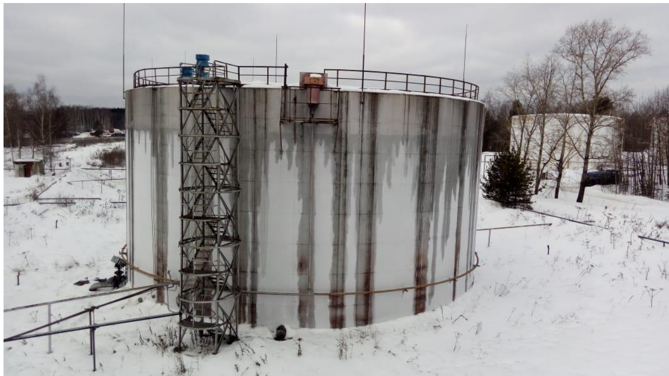
Рисунок 1 - Общий вид резервуара вертикального стального цилиндрического РВС-5000
