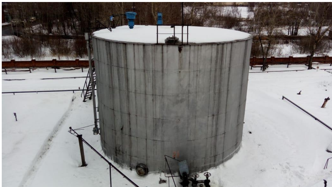
Рисунок 2 - Общий вид резервуара вертикального стального цилиндрического РВСП-700
