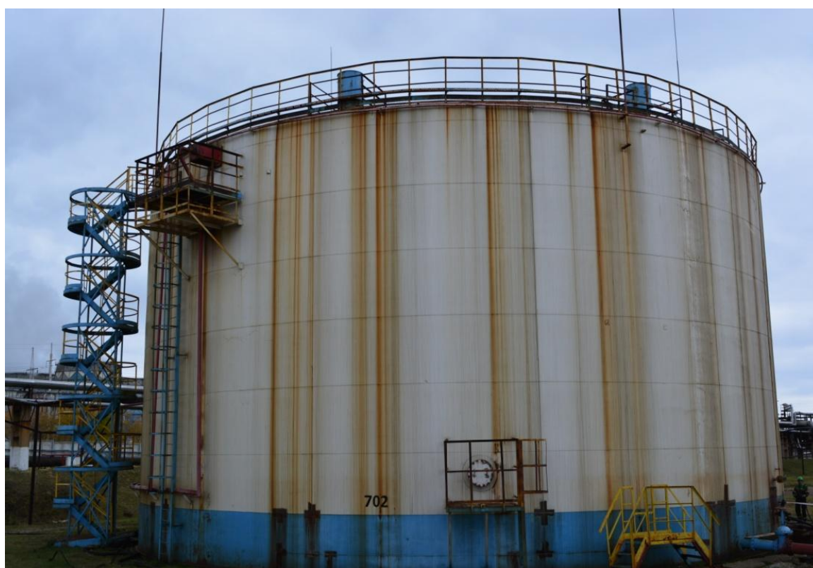
Рисунок 2 - Общий вид резервуара РВСП-5000 № 702
