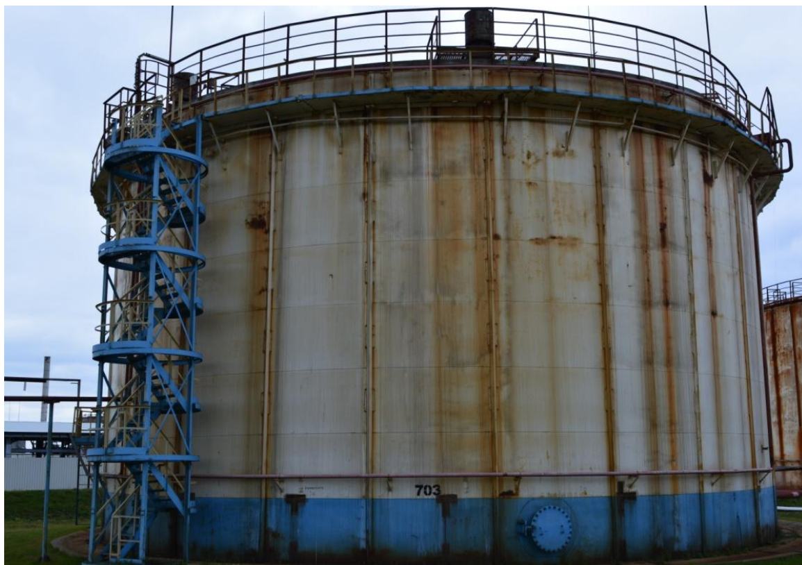
Рисунок 3 - Общий вид резервуара РВСП-5000 № 703
