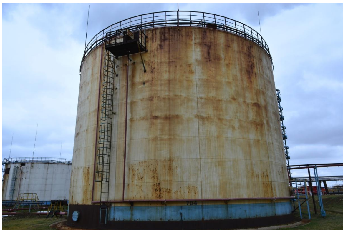
Рисунок 4 - Общий вид резервуара РВСП-5000 № 704
