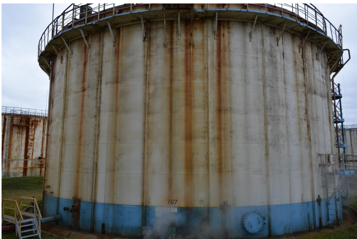
Рисунок 6 - Общий вид резервуара РВСП-5000 № 707
