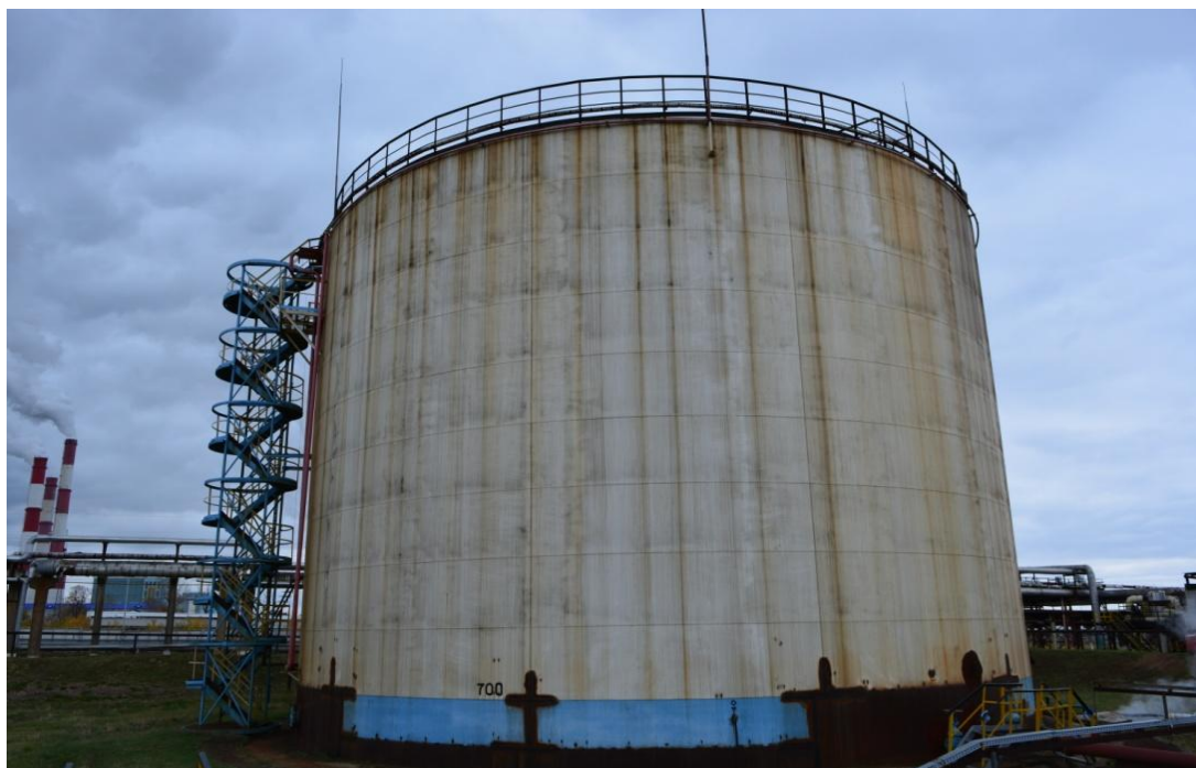
Рисунок 1 - Общий вид резервуара РВС-5000 № 700
