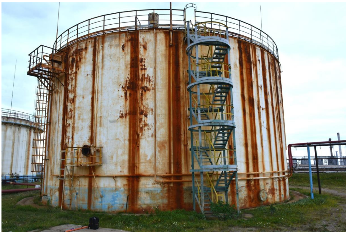
Рисунок 5 - Общий вид резервуара РВСП-5000 № 706
