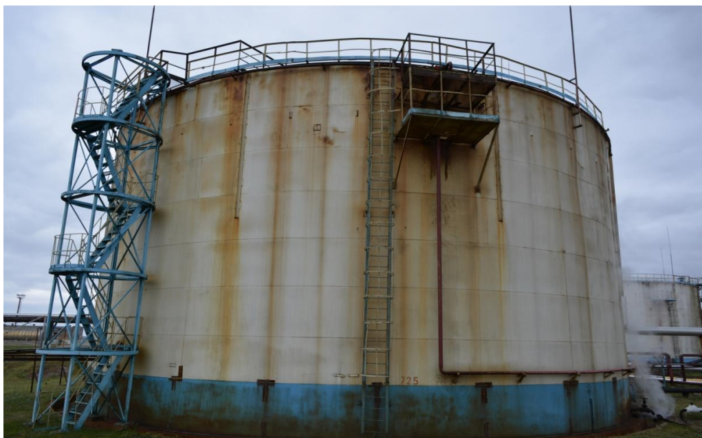
Рисунок 8 - Общий вид резервуара РВС-5000 № 725
