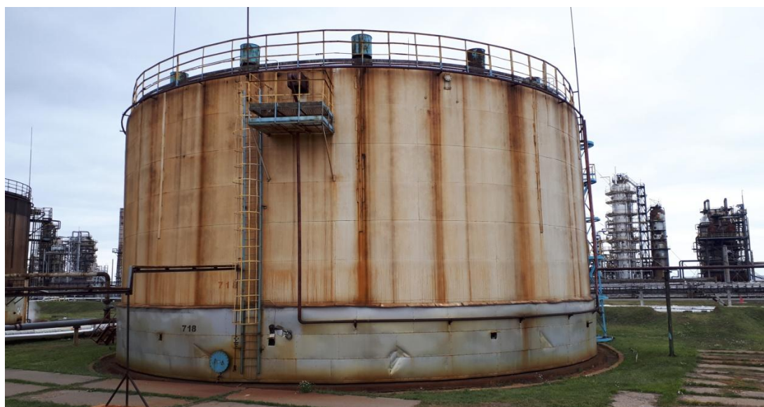
Рисунок 15 - Общий вид видимой части конструкции резервуара РВСП-5000 № 718
