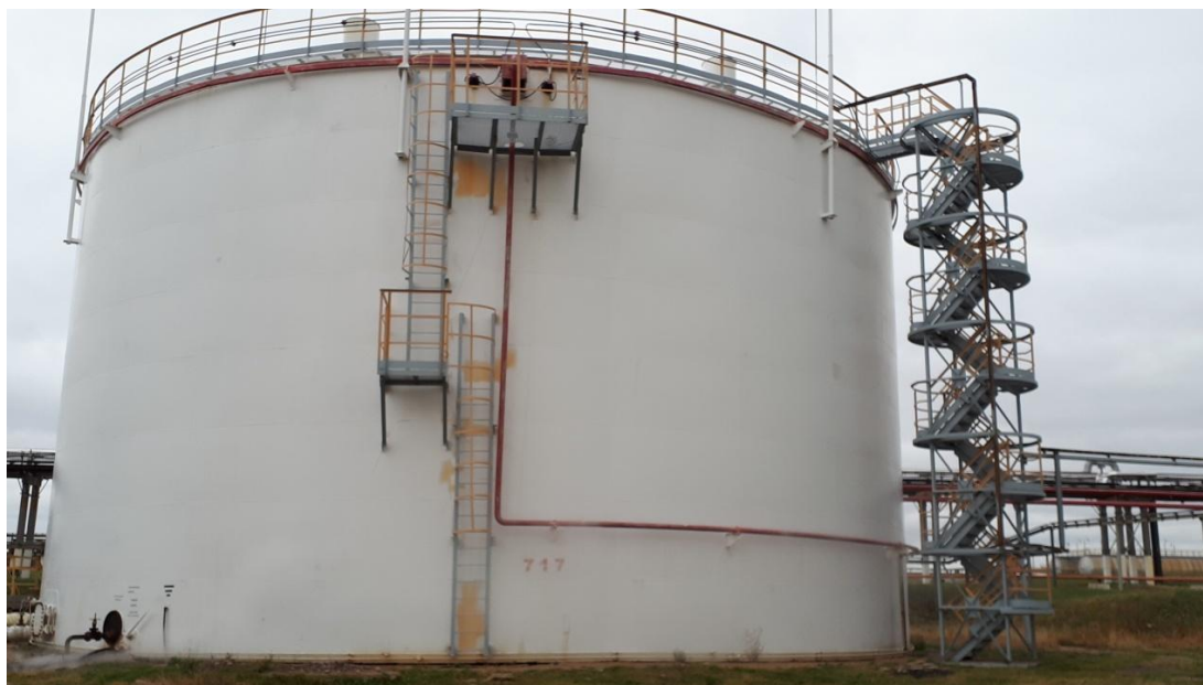
Рисунок 14 - Общий вид резервуара РВС-5000 № 717
