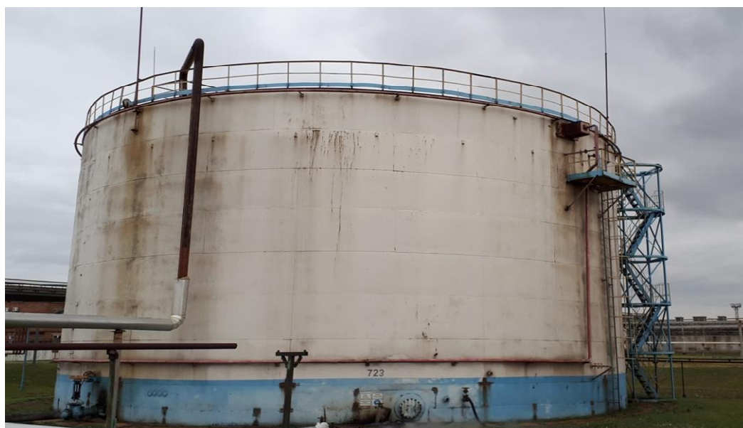
Рисунок 6 - Общий вид резервуара РВС-5000 № 723
