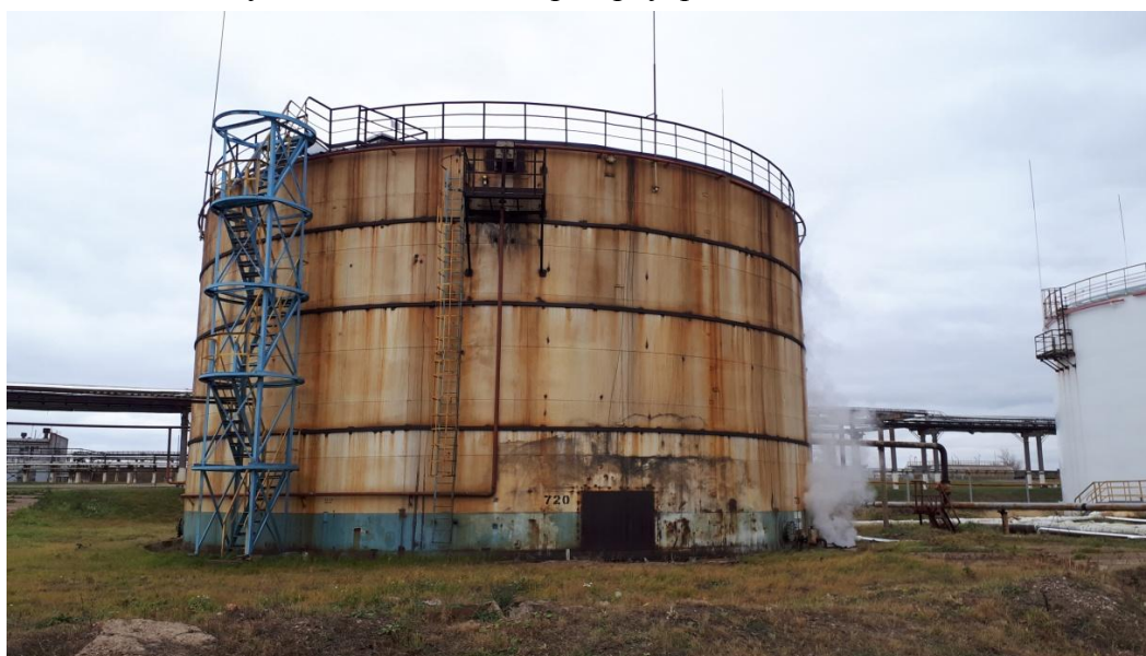
Рисунок 3 - Общий вид резервуара РВС-5000 № 720
