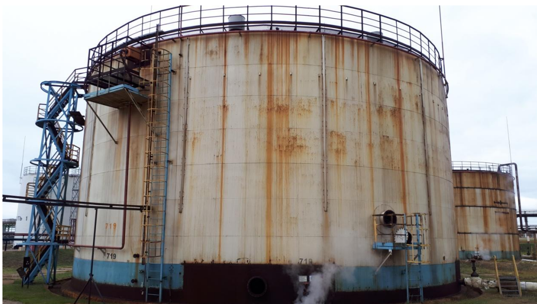
Рисунок 16 - Общий вид видимой части конструкции резервуара РВСП-5000 № 719
