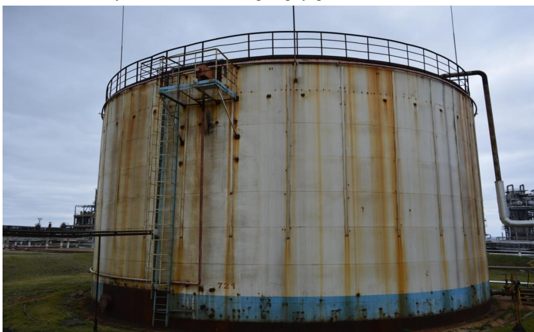
Рисунок 4 - Общий вид резервуара РВС-5000 № 721
