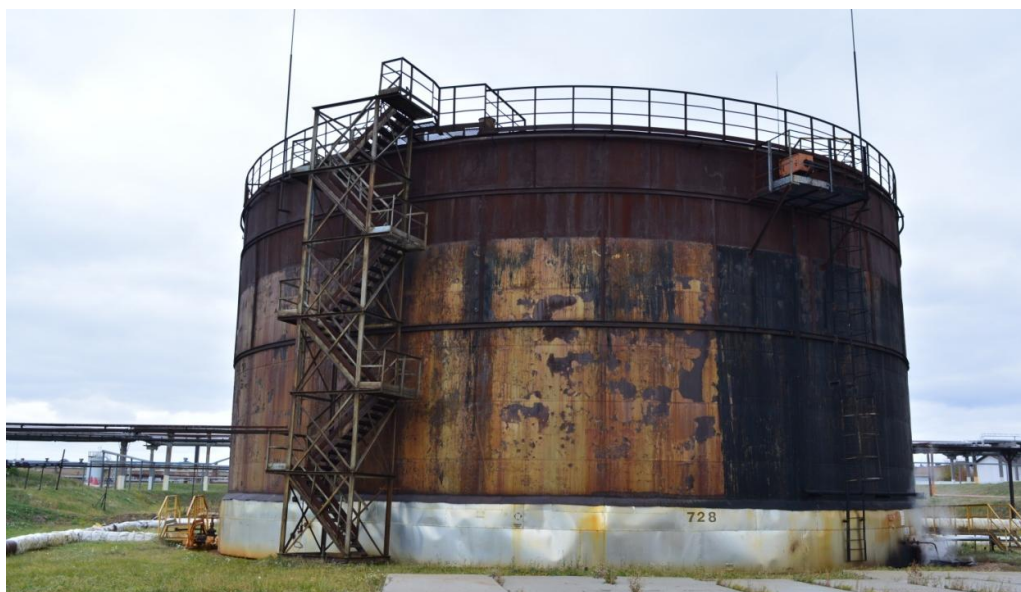
Рисунок 10 - Общий вид резервуара РВС-5000 № 728
