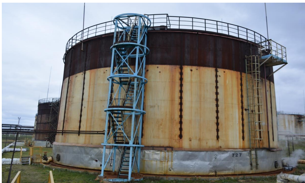
Рисунок 9 - Общий вид резервуара РВС-5000 № 727
