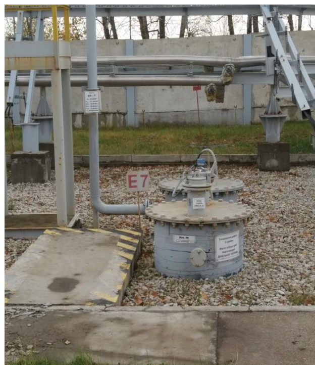
Рисунок 3 - Общий вид видимых частей конструкции резервуаров РГС-12,5 № Еп-6 (слева), № Еп-7 (справа)
