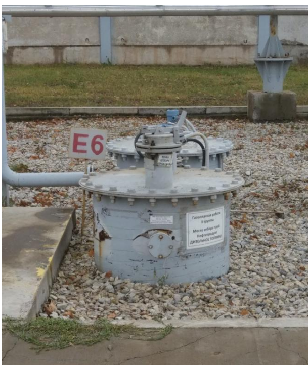
Рисунок 3 - Общий вид видимых частей конструкции резервуаров РГС-12,5 № Еп-6 (слева), № Еп-7 (справа)
