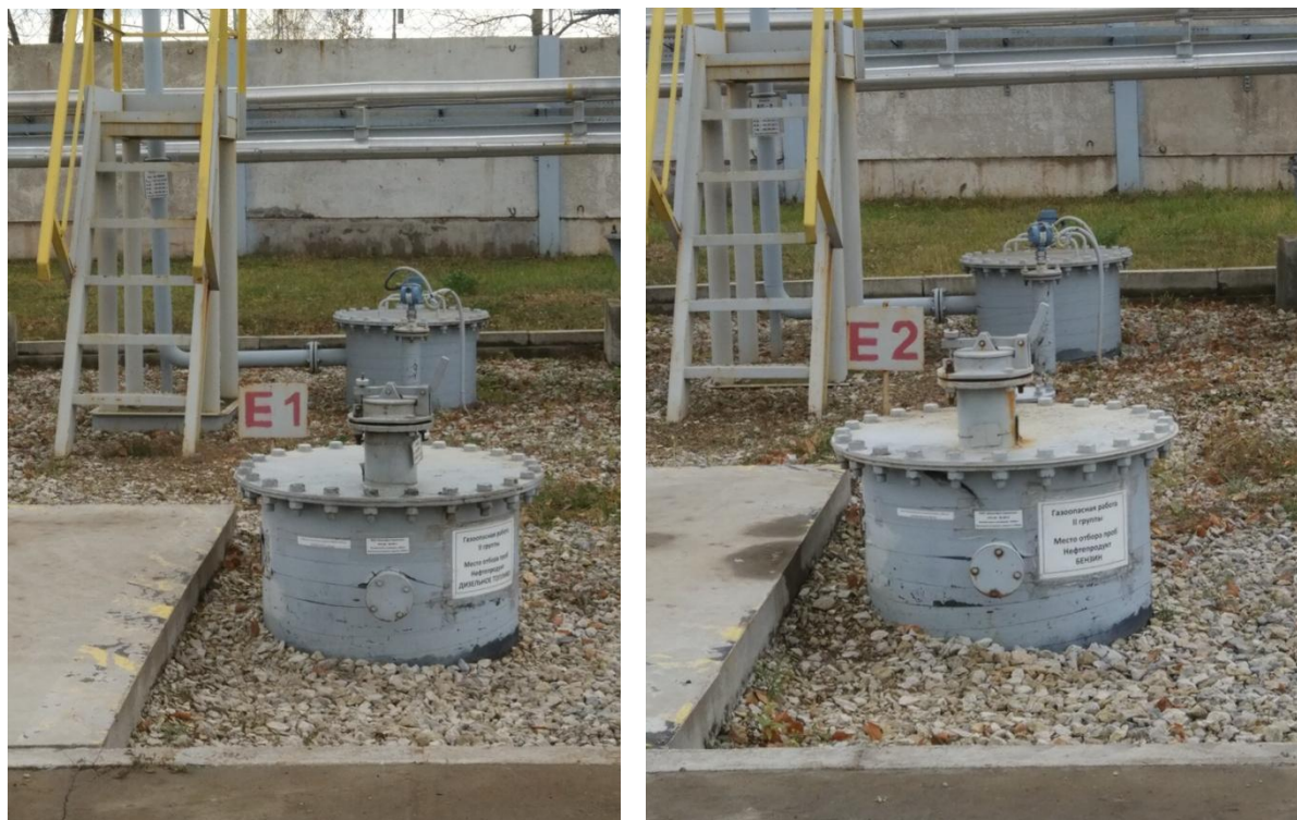
Рисунок 1 - Общий вид видимых частей конструкции резервуаров РГС-40 № Еп-1 (слева), № Еп-2 (справа)
