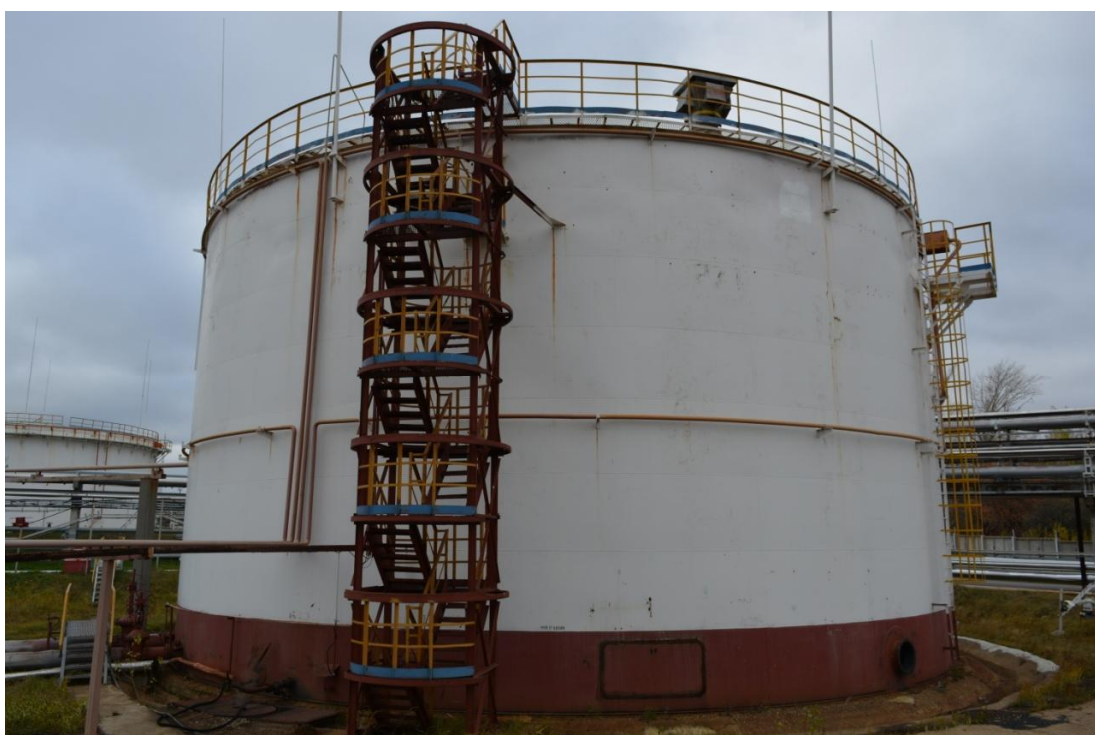
Рисунок 1 - Общий вид резервуара РВС-5000 № 271
