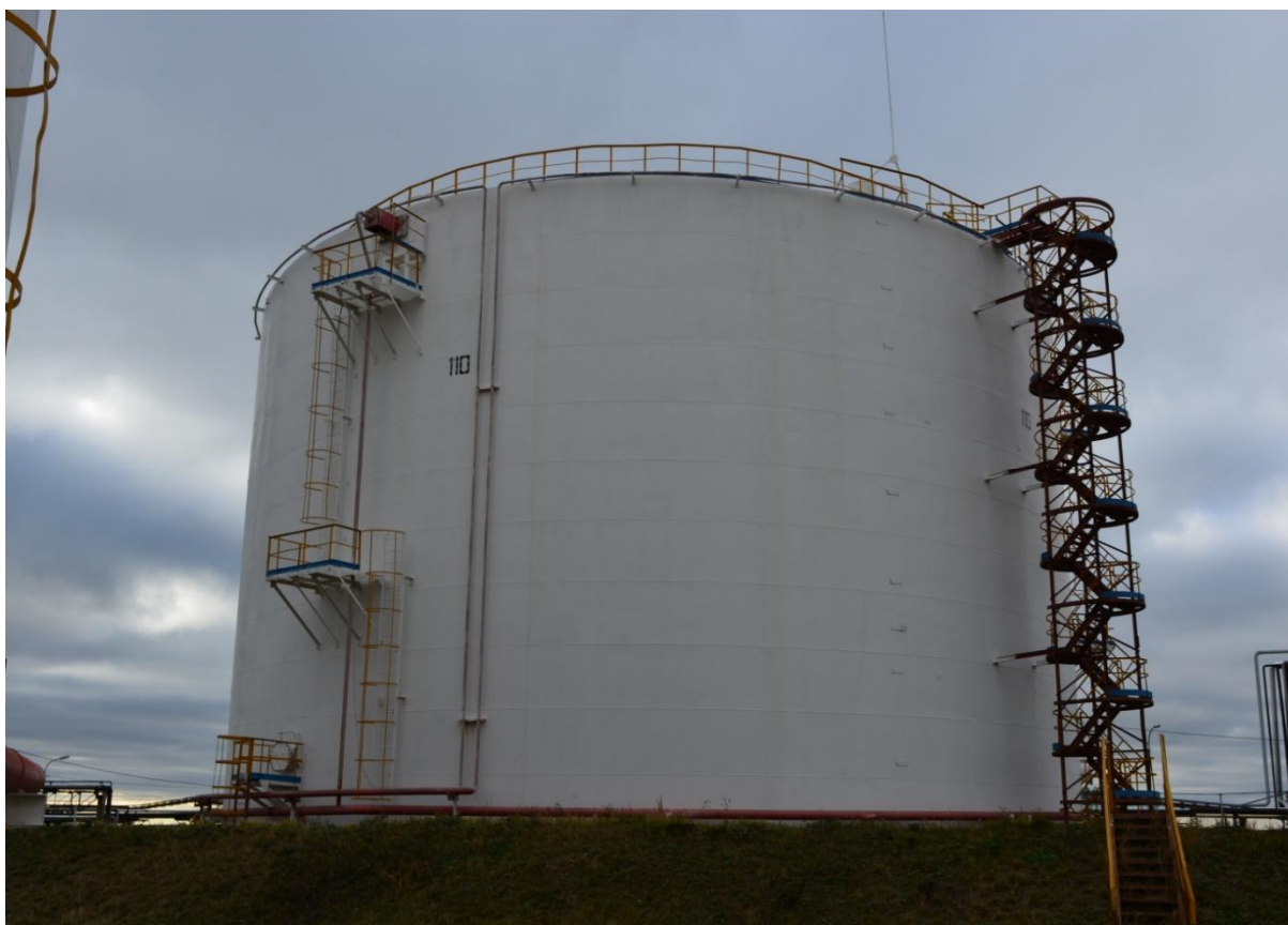
Рисунок 8 - Общий вид резервуара РВСП-10000 № 110
