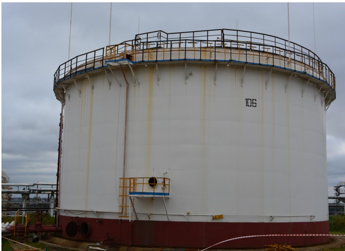
Рисунок 5 - Общий вид резервуара РВСП-5000 № 106
