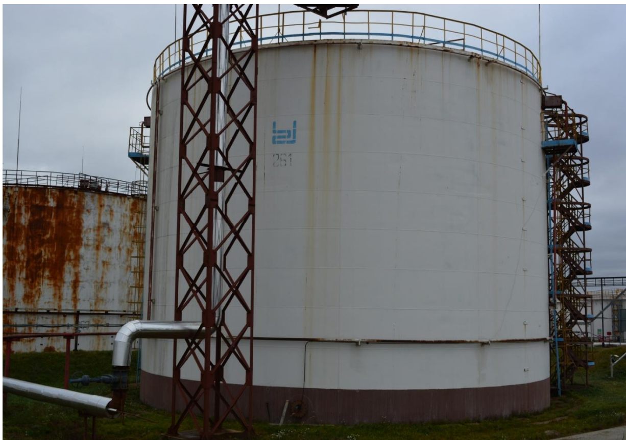
Рисунок 11 - Общий вид резервуара РВС-5000 № 261
