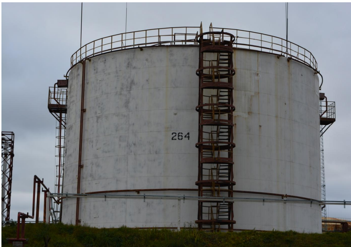
Рисунок 13 - Общий вид резервуара РВС-5000 № 264
