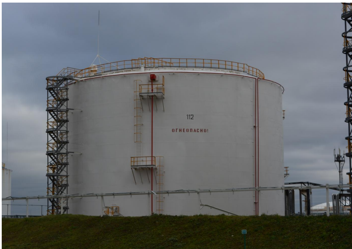
Рисунок 10 - Общий вид резервуара РВСП-10000 № 112
