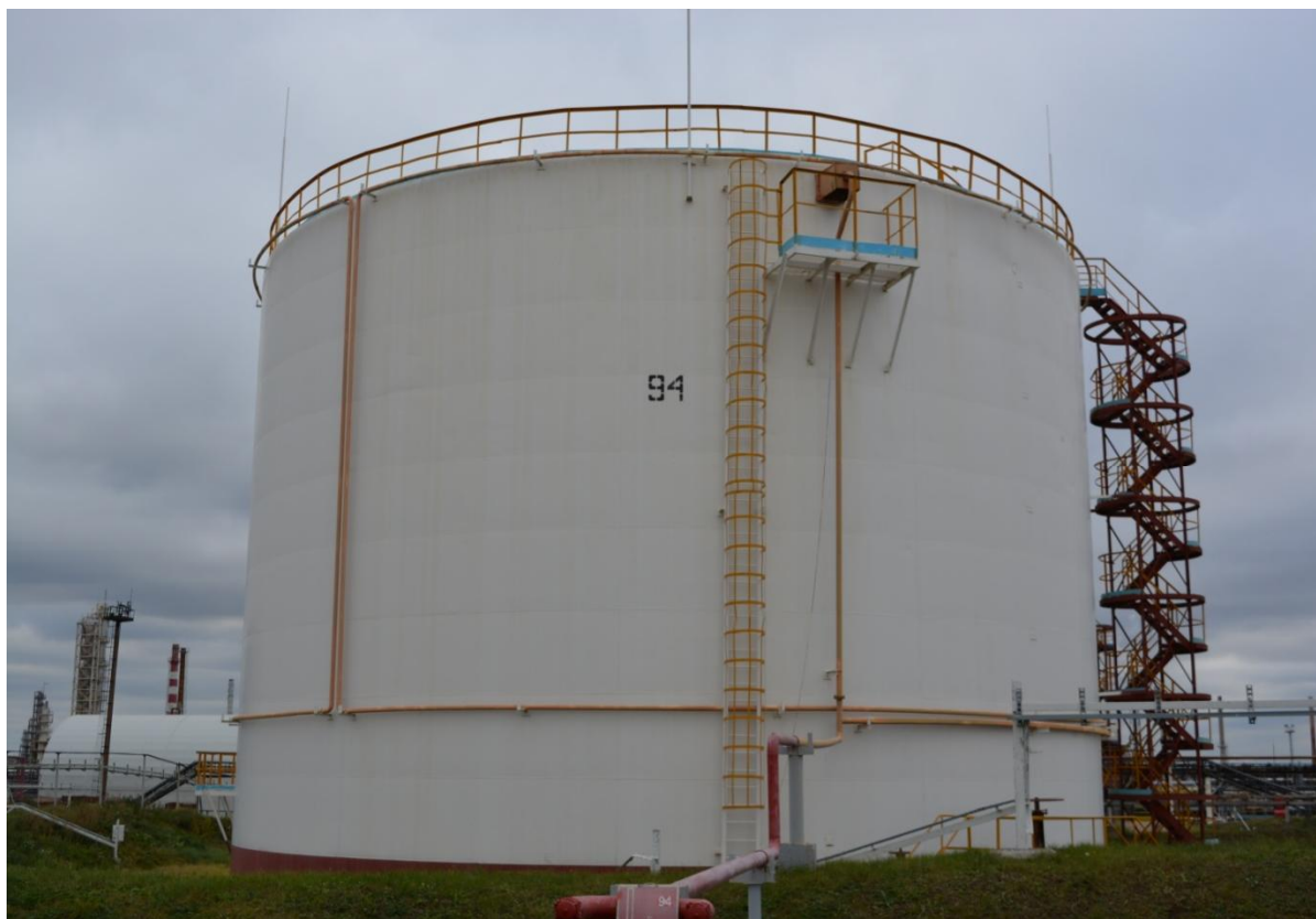
Рисунок 1 - Общий вид резервуара РВСП-5000 № 94
