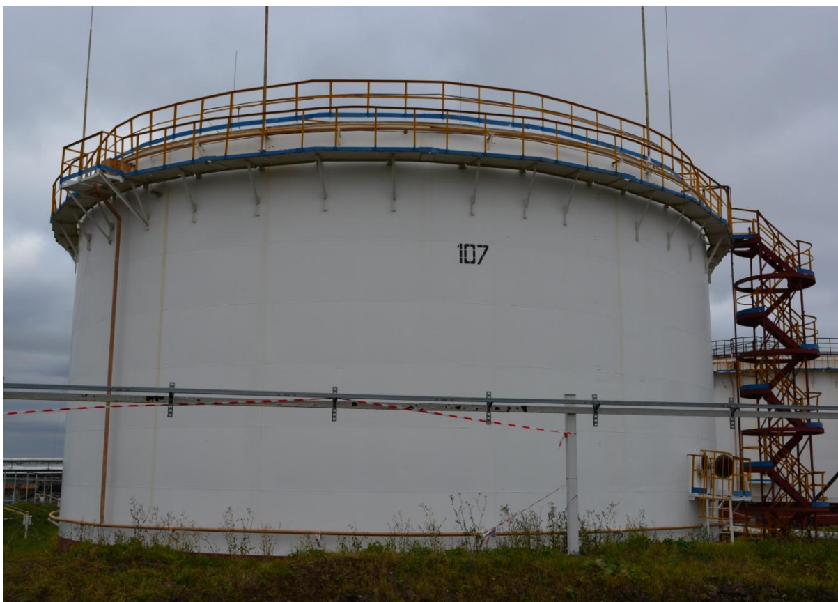
Рисунок 6 - Общий вид резервуара РВСП-5000 № 107
