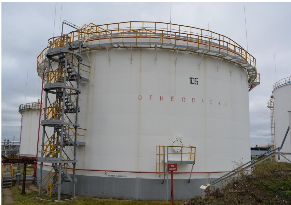
Рисунок 4 - Общий вид резервуара РВСП-5000 № 105
