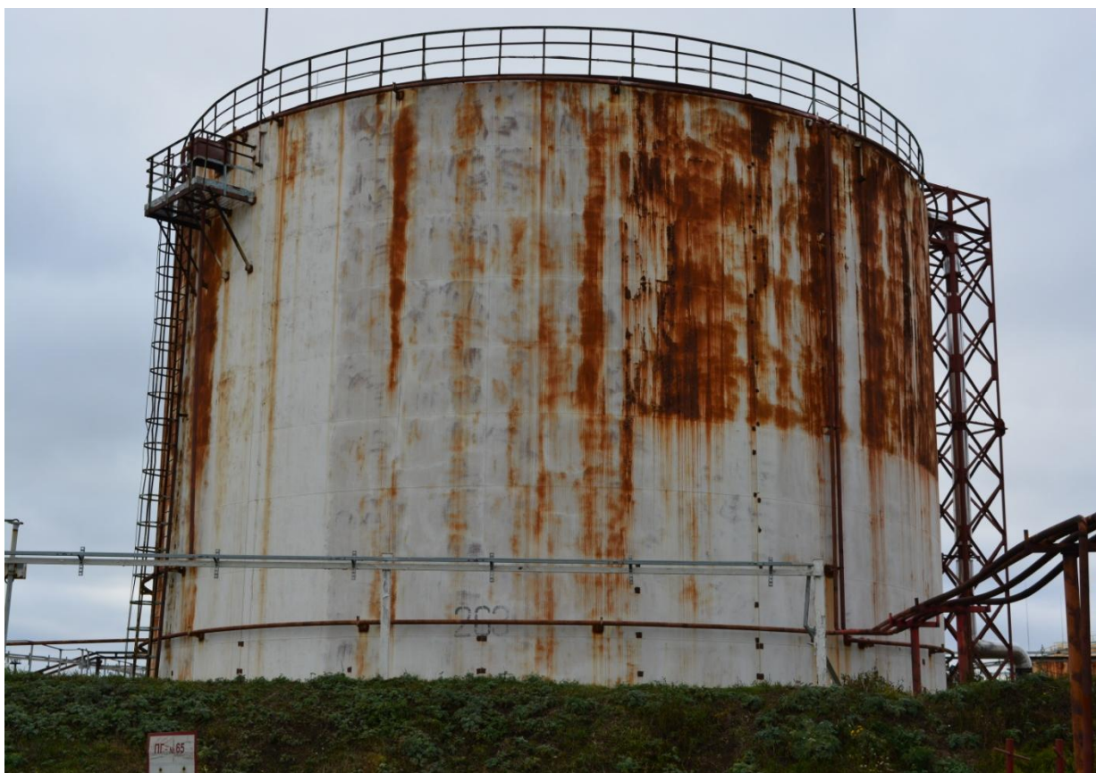
Рисунок 12 - Общий вид резервуара РВС-5000 № 263
