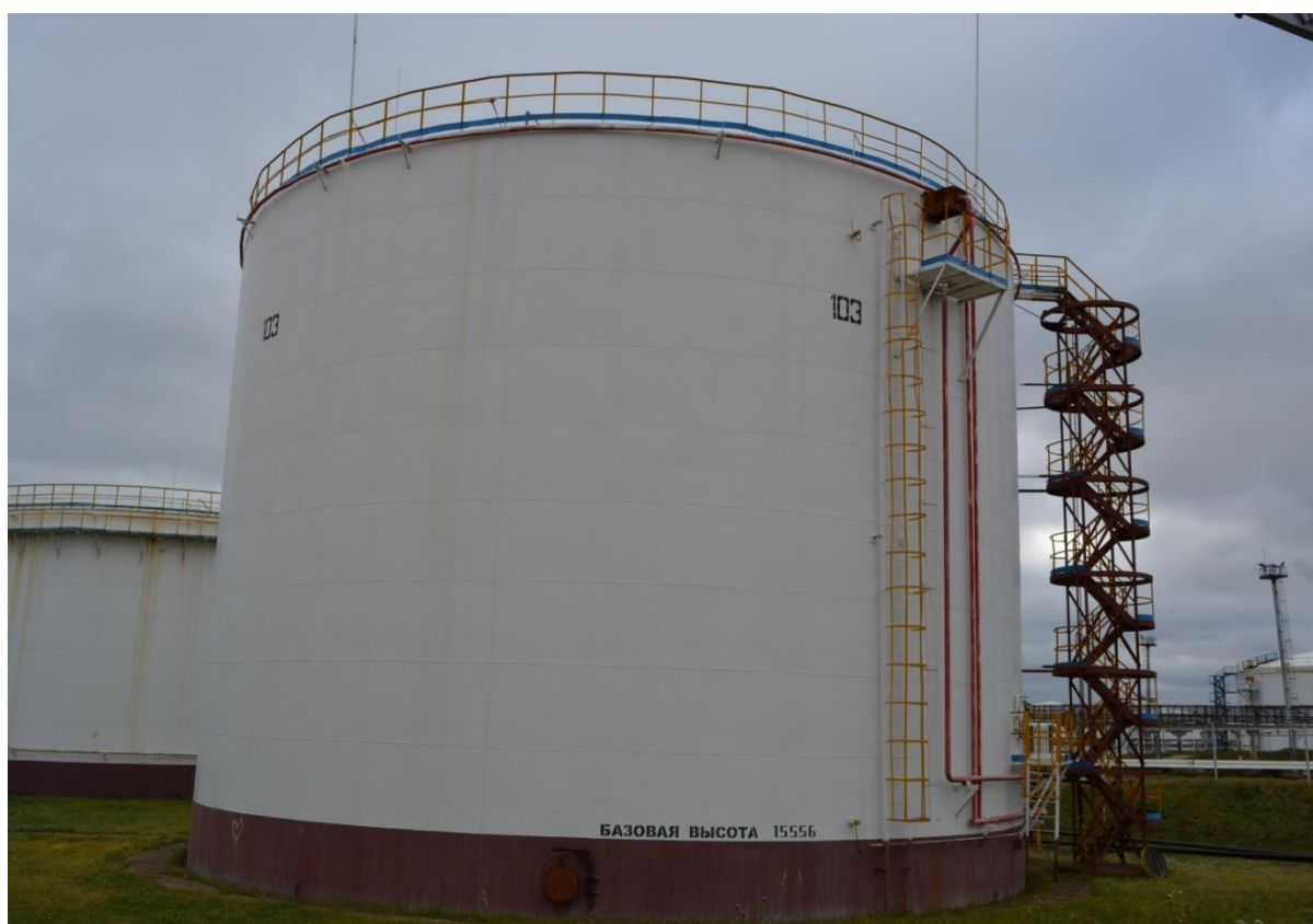
Рисунок 2 - Общий вид резервуара РВСП-5000 № 103
