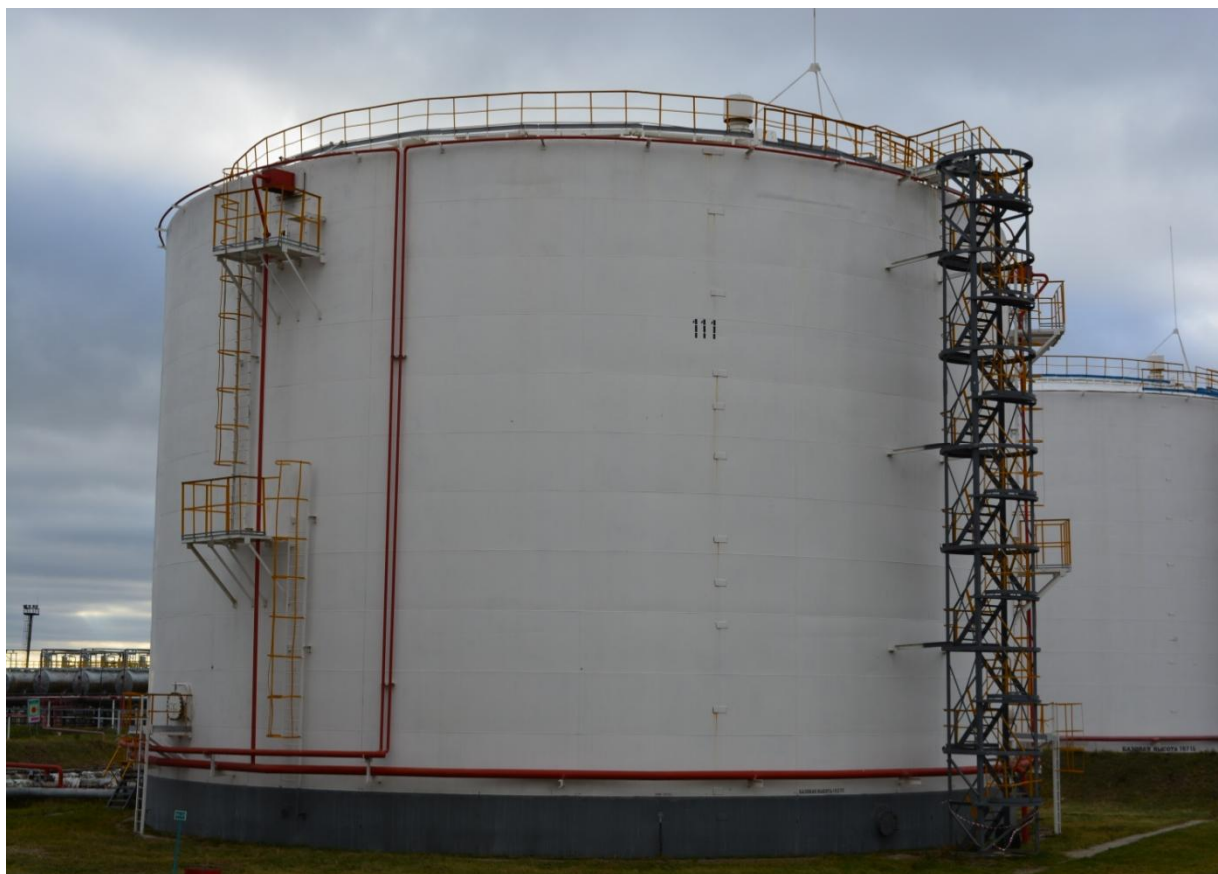
Рисунок 9 - Общий вид резервуара РВСП-10000 № 111
