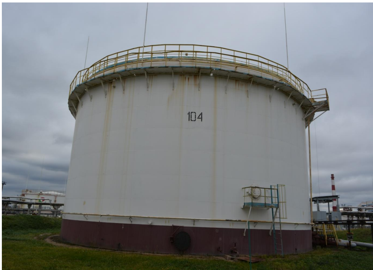
Рисунок 3 - Общий вид резервуара РВСП-5000 № 104
