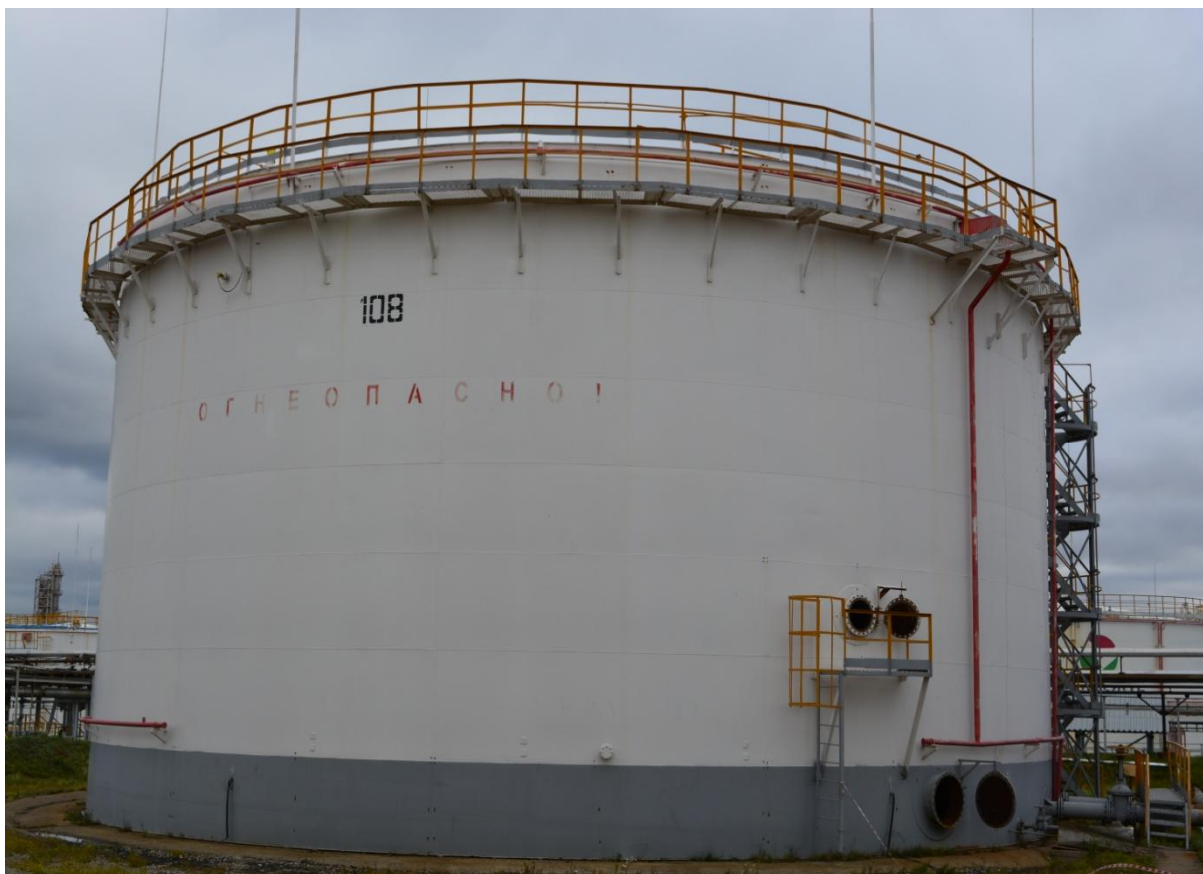
Рисунок 7 - Общий вид резервуара РВСП-5000 № 108
