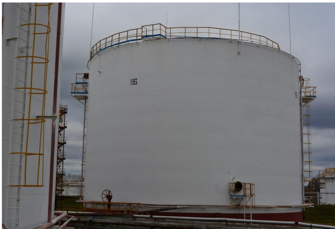
Рисунок 4 - Общий вид резервуара РВСП-5000 № 116
