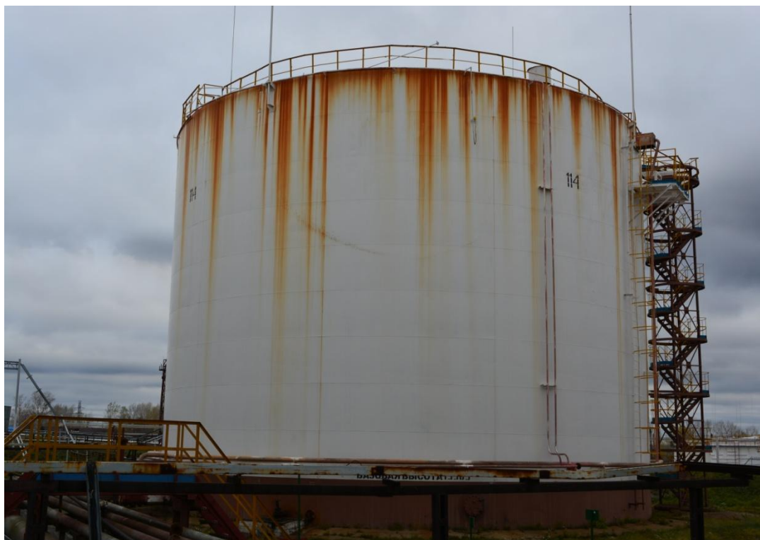
Рисунок 2 - Общий вид резервуара РВСП-5000 № 114
