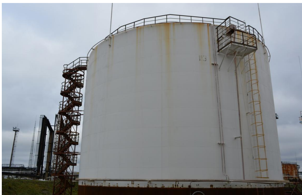
Рисунок 1 - Общий вид резервуара РВСП-5000 № 113
