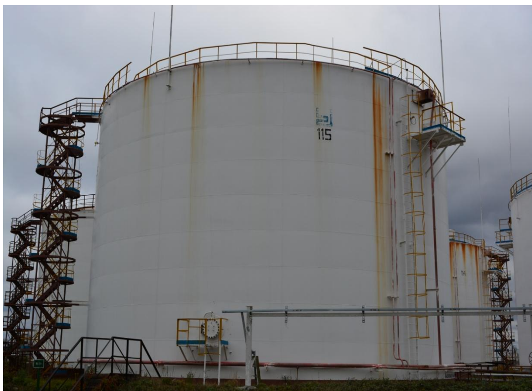
Рисунок 3 - Общий вид резервуара РВСП-5000 № 115
