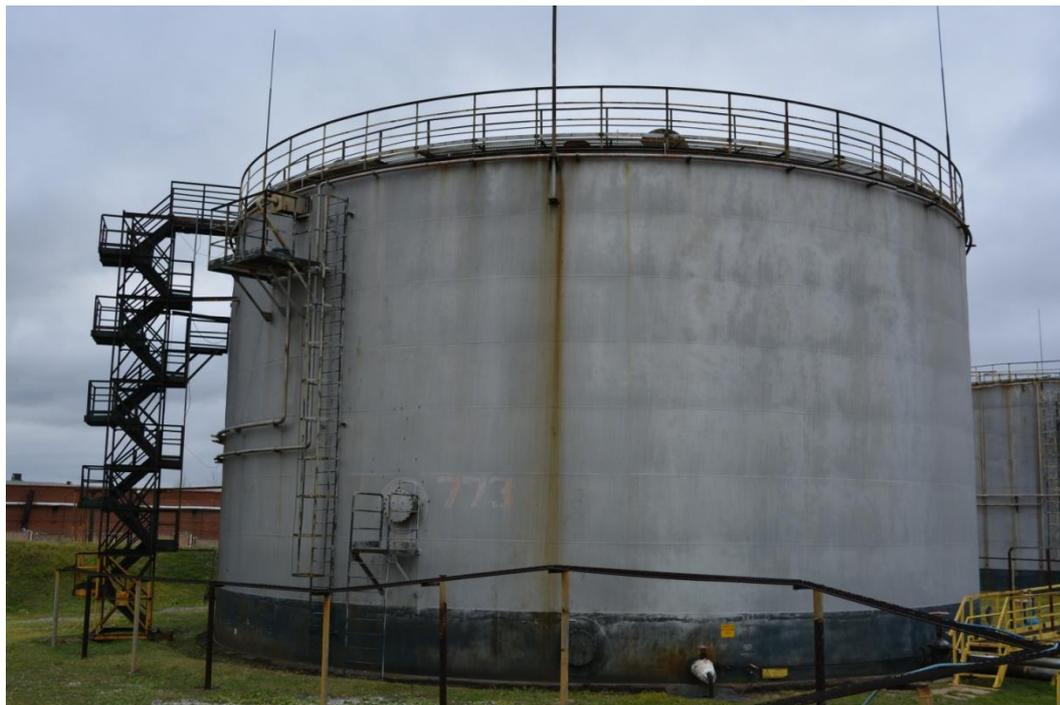
Рисунок 2 - Общий вид резервуара РВСП-5000 № 773
