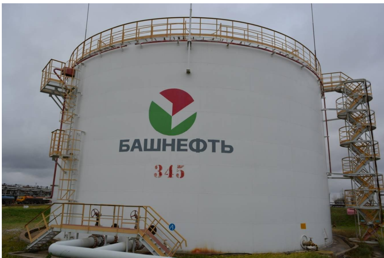
Рисунок 14 - Общий вид резервуара РВСП-5000 № 345
