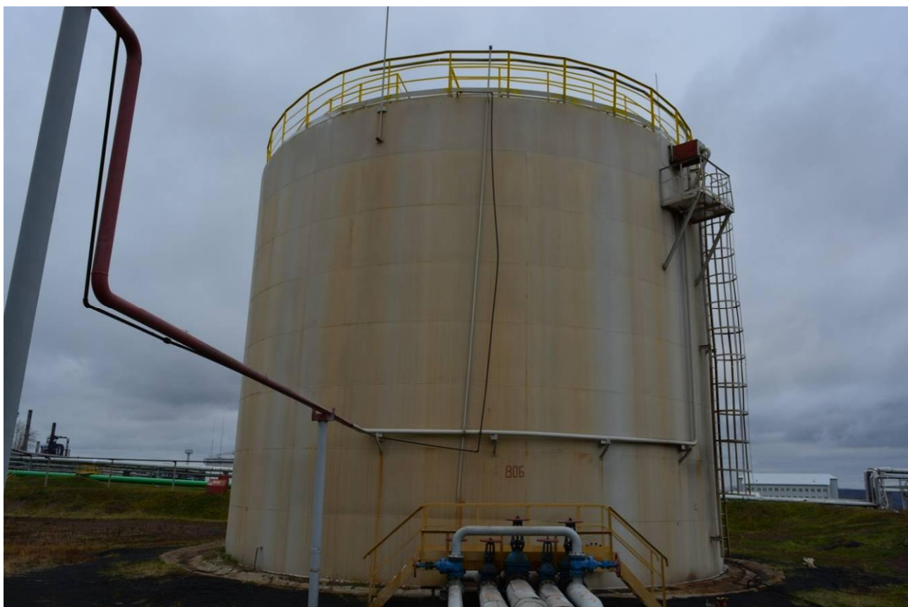
Рисунок 12 - Общий вид резервуара РВС-2000 № 806
