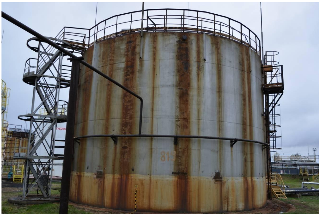
Рисунок 6 - Общий вид резервуара РВС-1000 № 819
