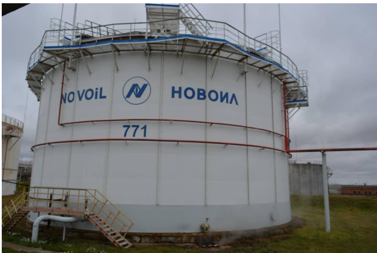
Рисунок 22 - Общий вид резервуара РВСП-5000 № 771
