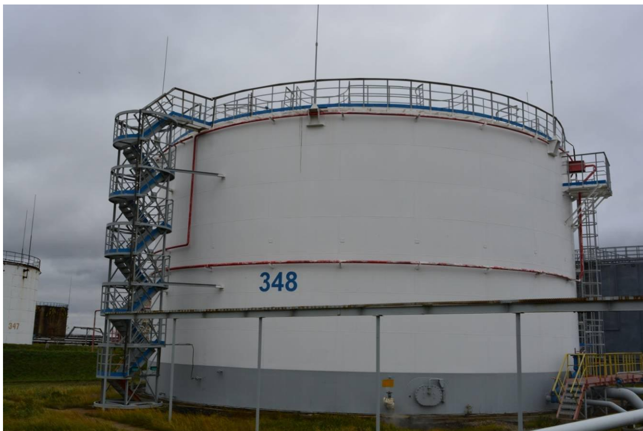
Рисунок 16 - Общий вид резервуара РВСП-5000 № 348
