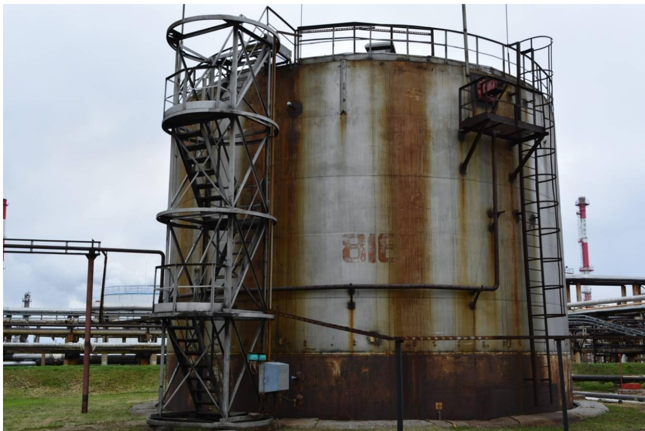
Рисунок 3 - Общий вид резервуара РВС-1000 № 816
