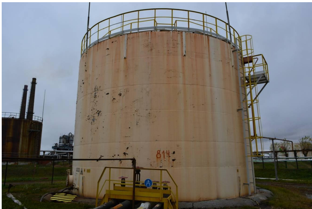
Рисунок 1 - Общий вид резервуара РВС-1000 № 814
