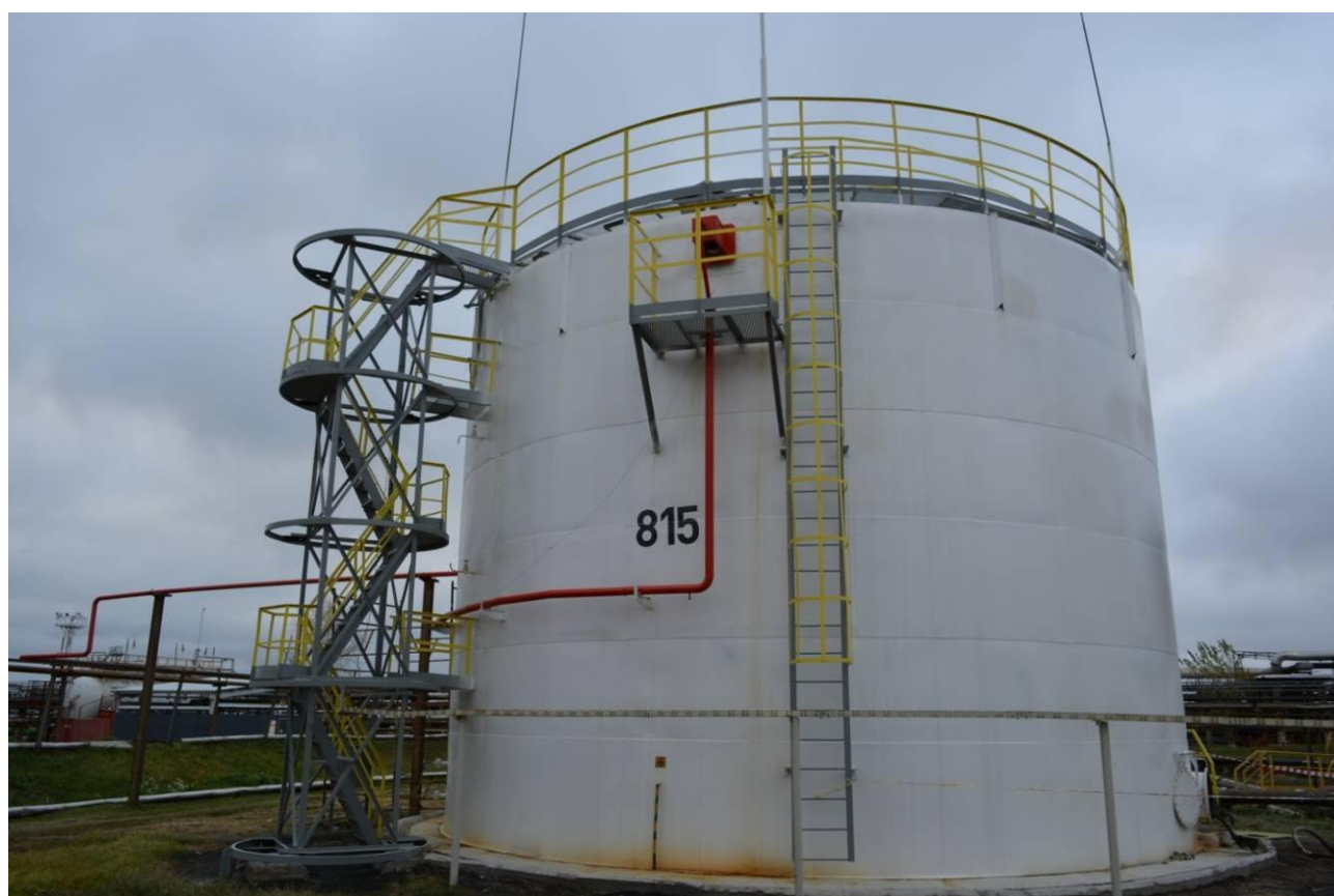
Рисунок 2 - Общий вид резервуара РВС-1000 № 815
