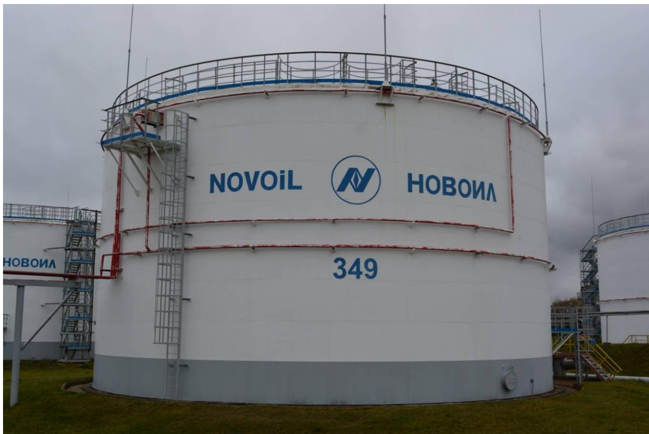
Рисунок 17 - Общий вид резервуара РВСП-5000 № 349
