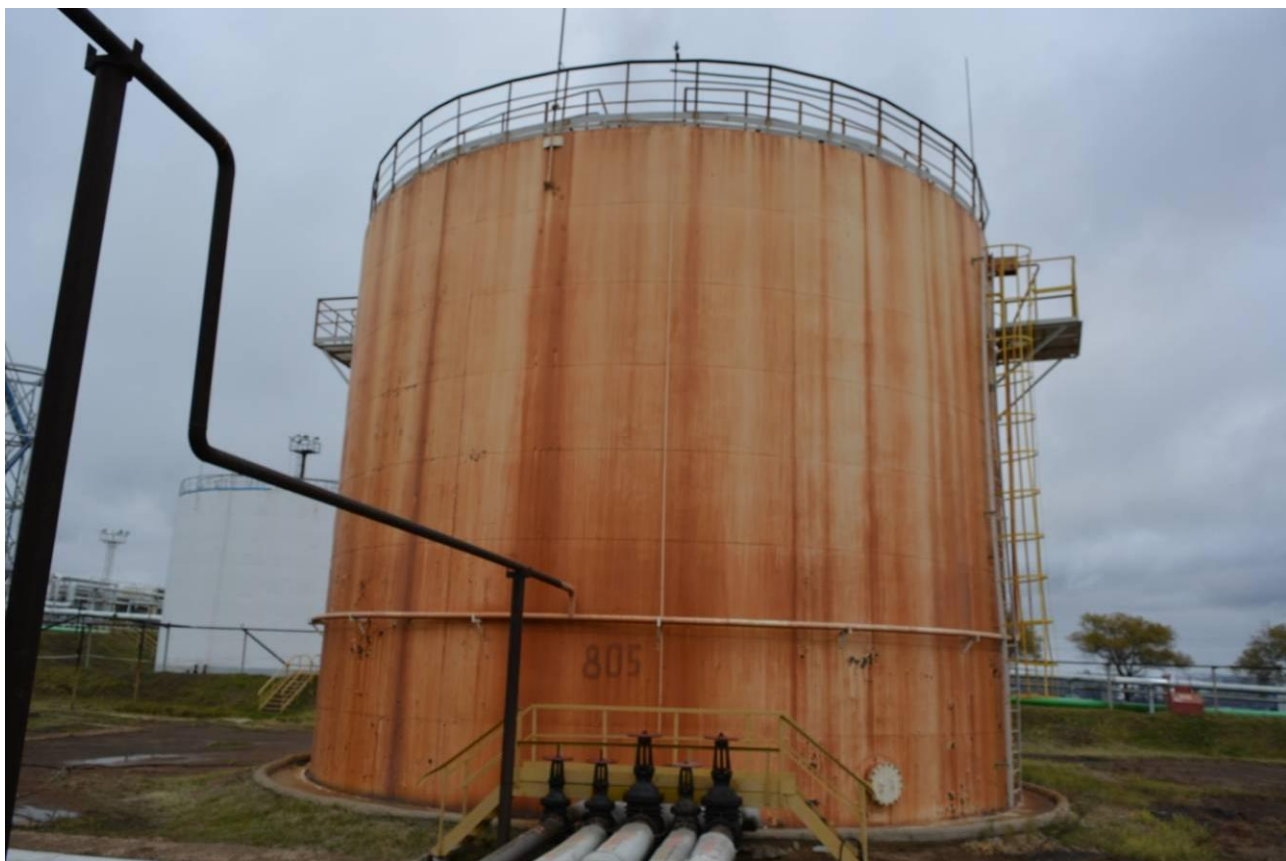
Рисунок 11 - Общий вид резервуара РВС-2000 № 805
