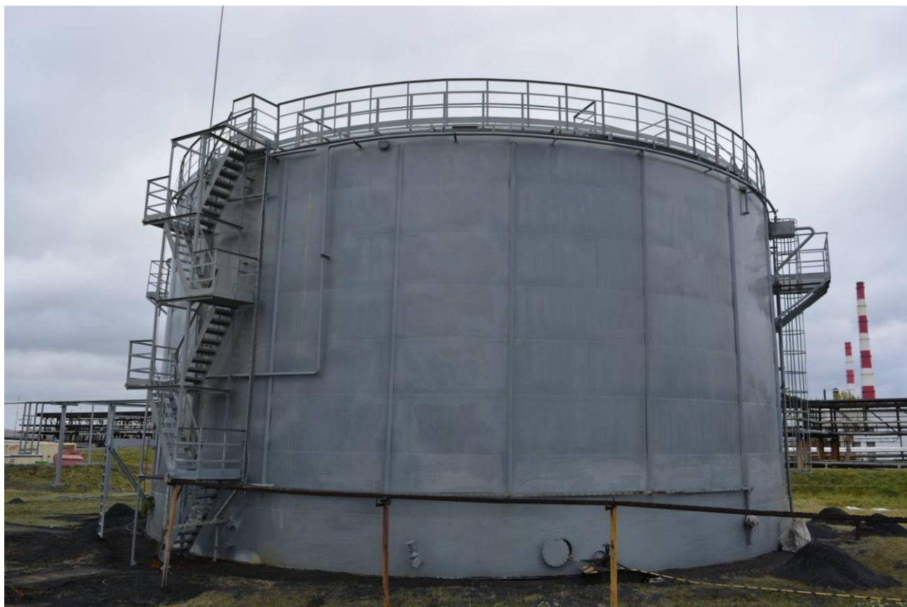
Рисунок 19 - Общий вид резервуара РВСП-5000 № 351
