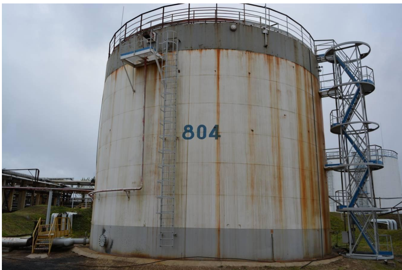
Рисунок 10 - Общий вид резервуара РВС-2000 № 804
