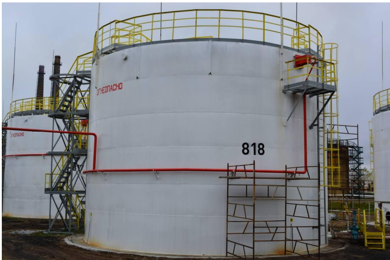
Рисунок 5 - Общий вид резервуара РВС-1000 № 818
