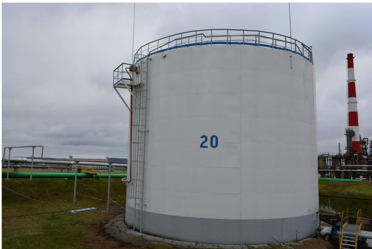
Рисунок 8 - Общий вид резервуара РВС-2000 № 20
