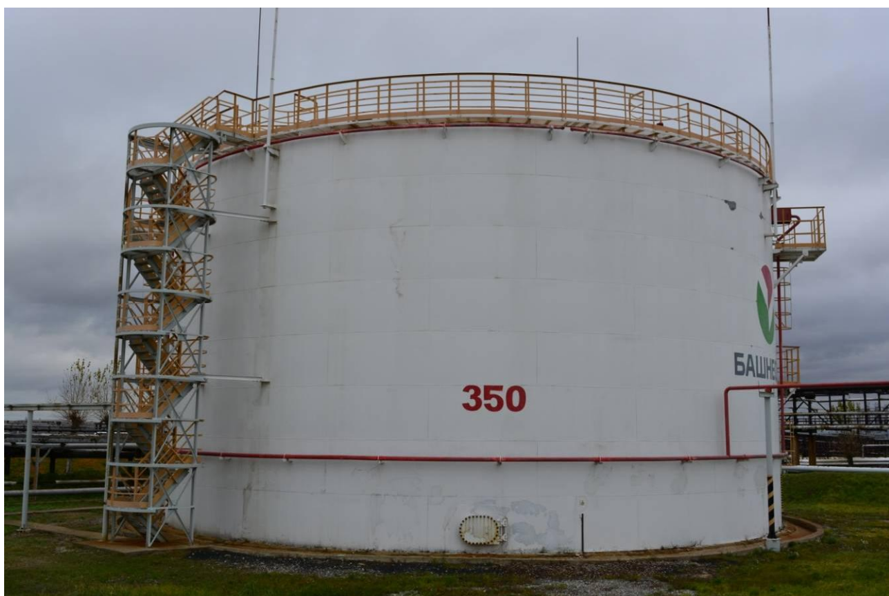
Рисунок 18 - Общий вид резервуара РВСП-5000 № 350
