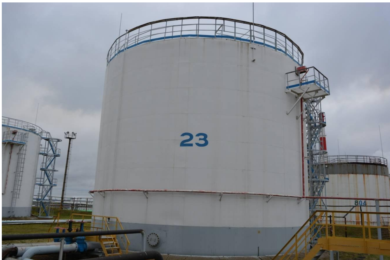
Рисунок 9 - Общий вид резервуара РВС-2000 № 23
