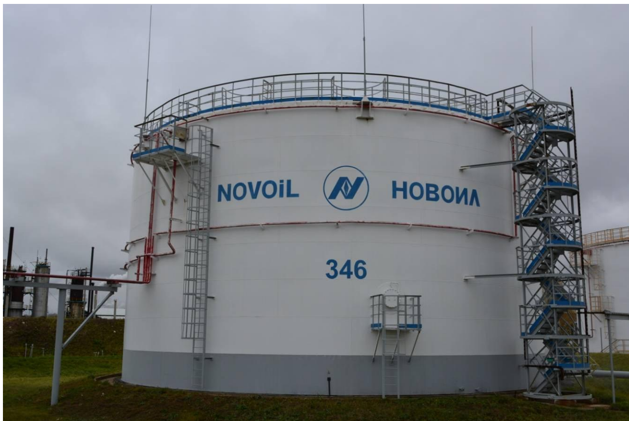
Рисунок 15 - Общий вид резервуара РВСП-5000 № 346
