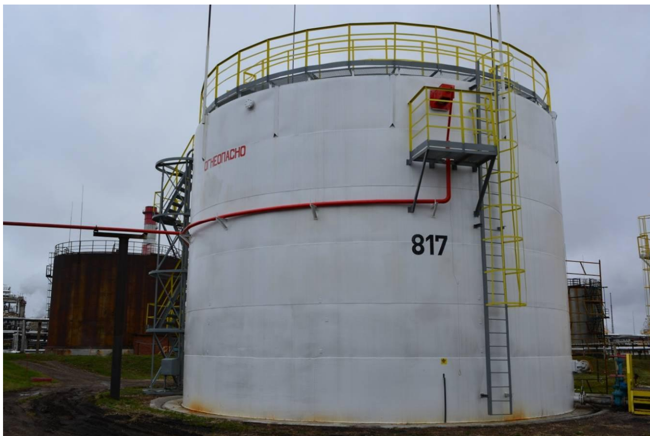
Рисунок 4 - Общий вид резервуара РВС-1000 № 817
