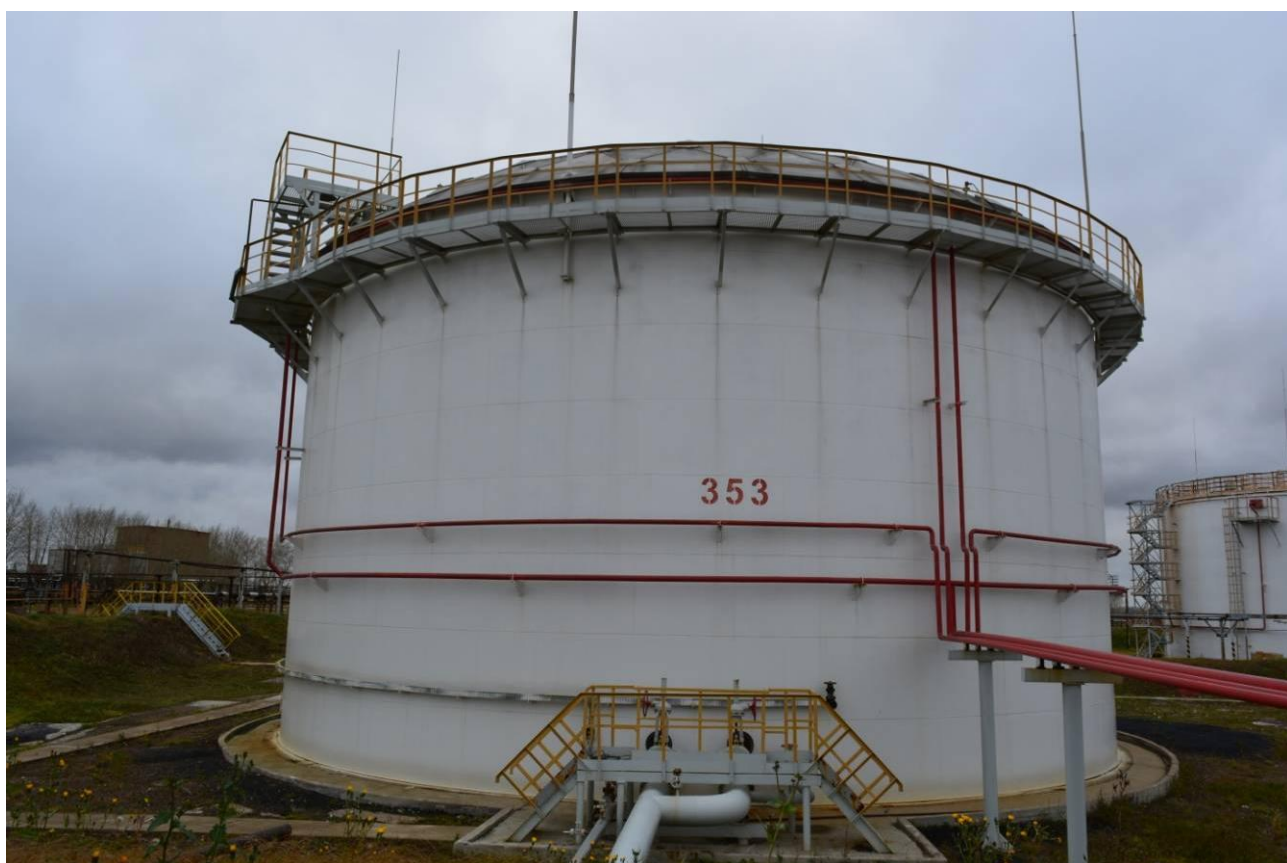
Рисунок 20 - Общий вид резервуара РВСП-5000 № 353
