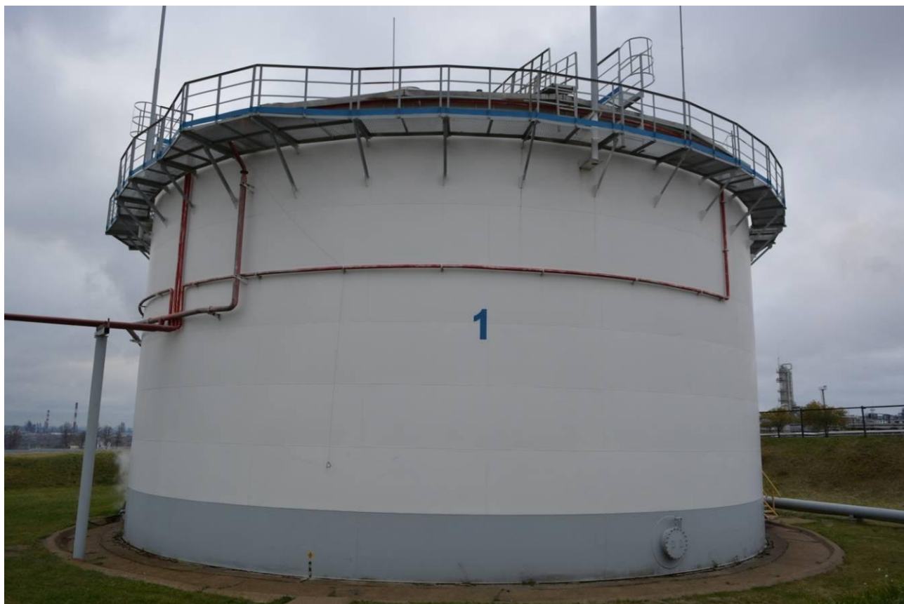
Рисунок 13 - Общий вид резервуара РВСП-5000 № 1
