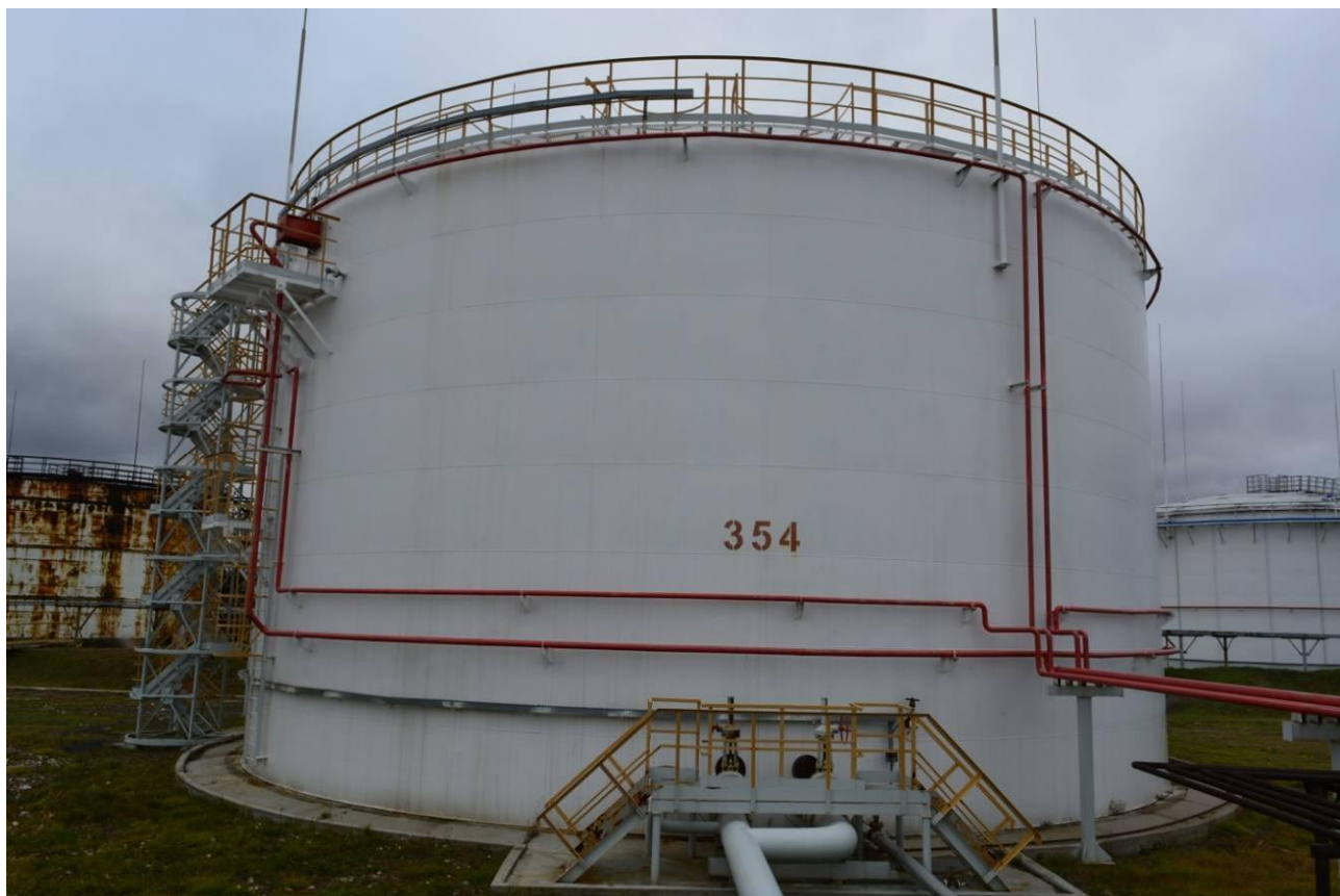
Рисунок 21 - Общий вид резервуара РВСП-5000 № 354
