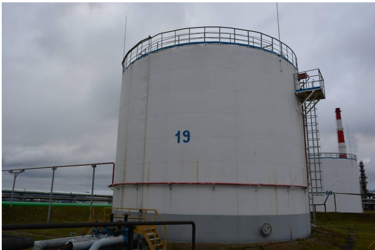
Рисунок 7 - Общий вид резервуара РВС-2000 № 19
