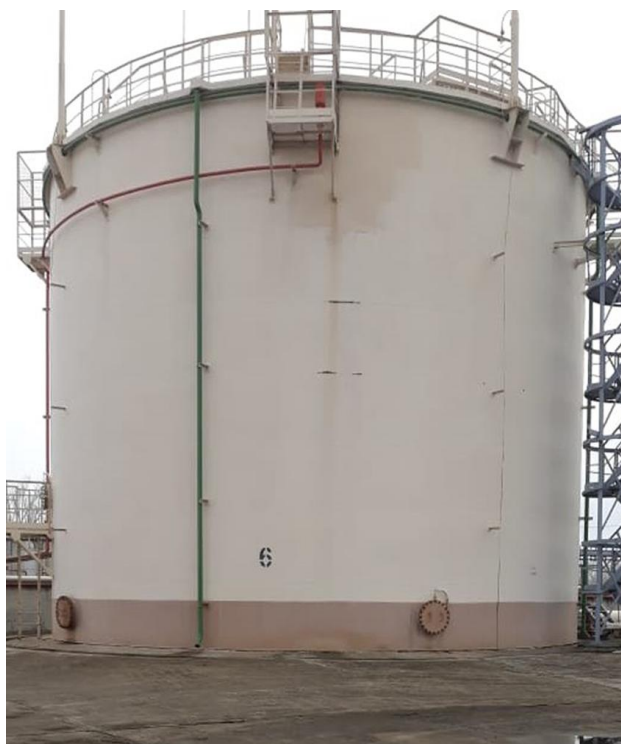
Рисунок 2 - Общий вид резервуара стального вертикального цилиндрического РВС-2000 зав. № 6
