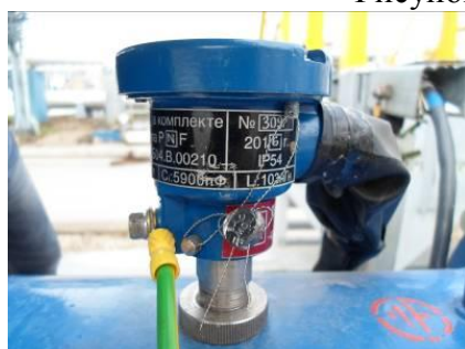
Рисунок 2 – Места установки пломб на ТПР
