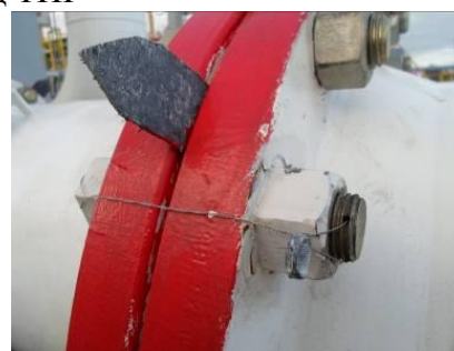
Рисунок 2 – Места установки пломб на ТПР
