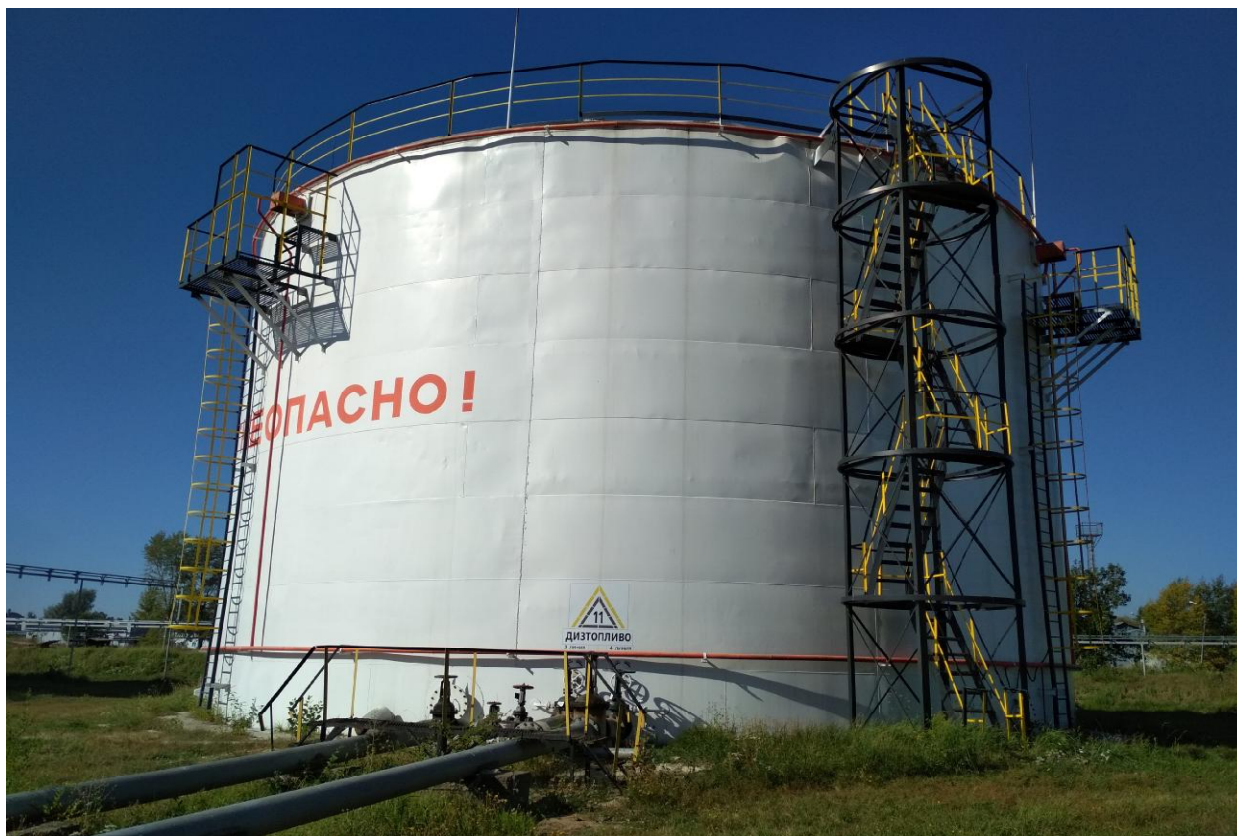
Рисунок 1 - Общий вид резервуара вертикального стального цилиндрического РВС-3000 № 11
