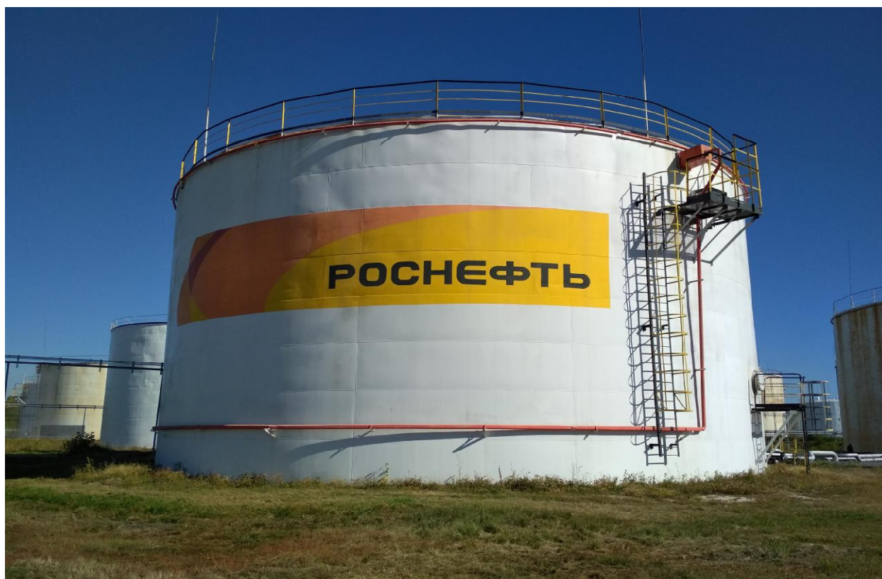
Рисунок 2- Общий вид резервуара вертикального стального цилиндрического РВС-5000 № 5
