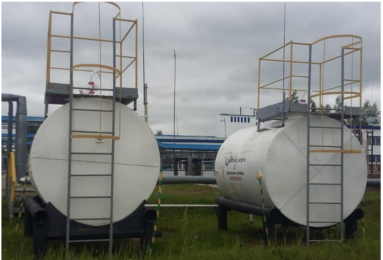
Рисунок 1 - Общий вид резервуаров стальных горизонтальных цилиндрических РГС-10
