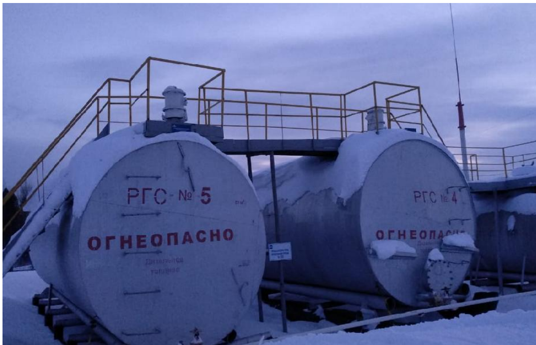
Рисунок 1 - Общий вид резервуаров
