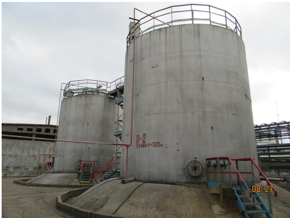
Рисунок 1 - Общий вид резервуаров стальных вертикальных цилиндрических РВС-300
