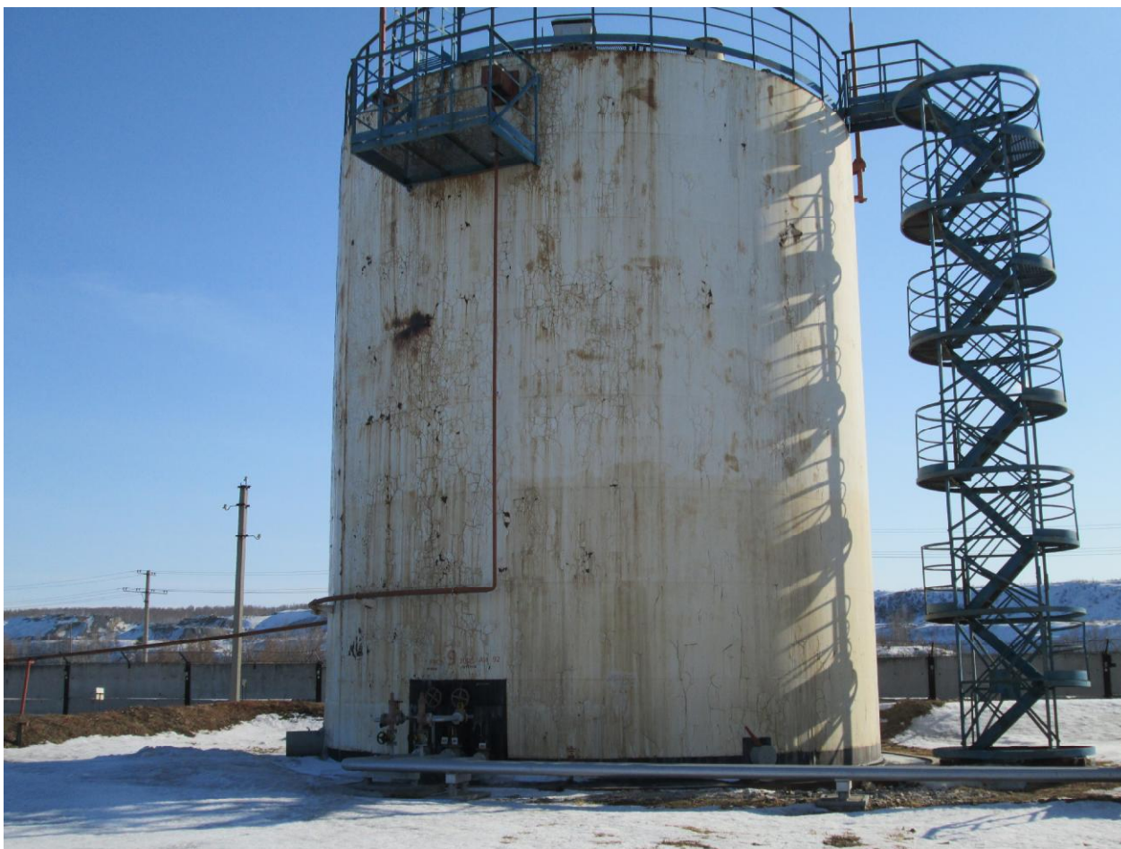
Рисунок 2 - Общий вид резервуара вертикального стального цилиндрического РВСП-1000
