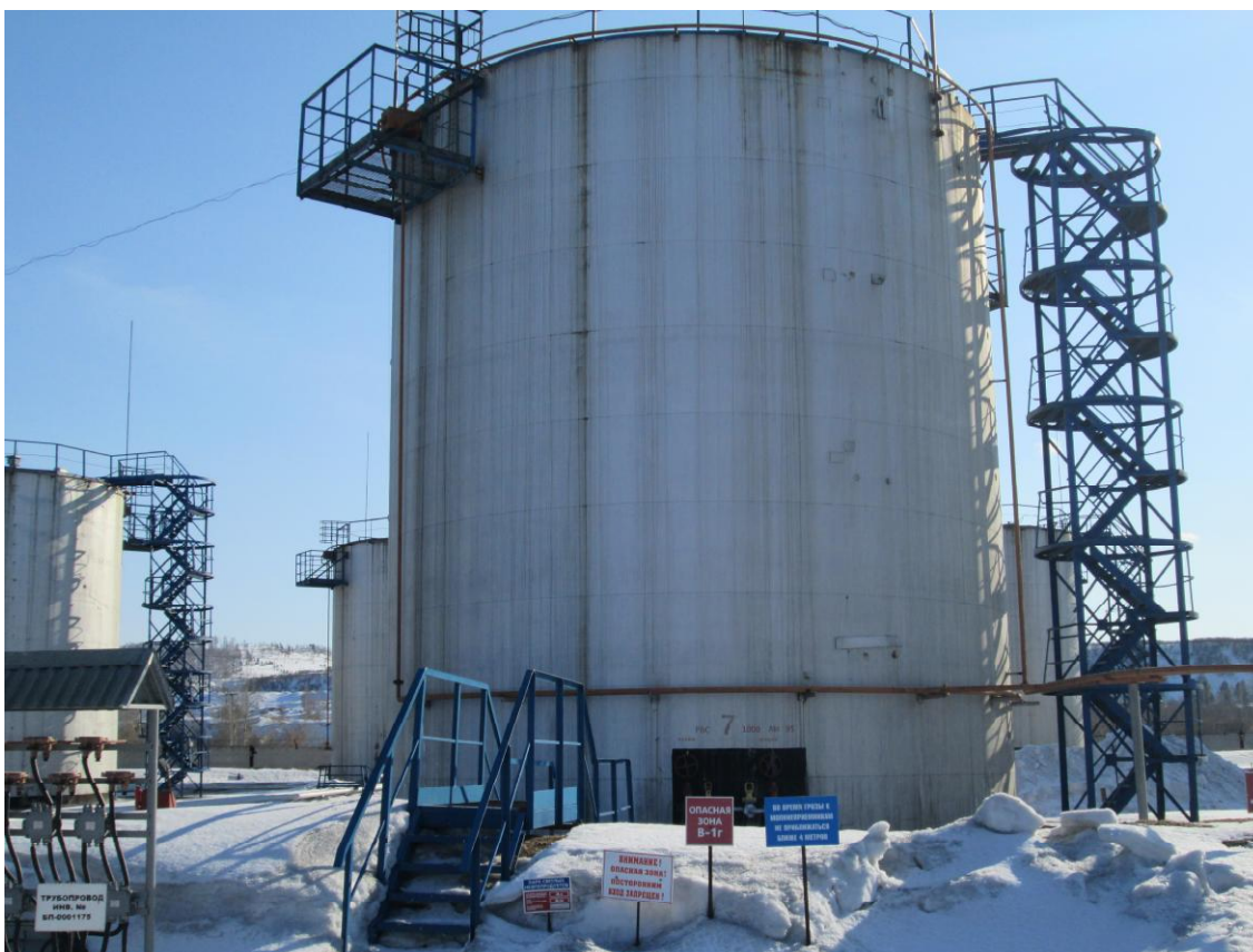
Рисунок 1 - Общий вид резервуара вертикального стального цилиндрического РВС-1000
