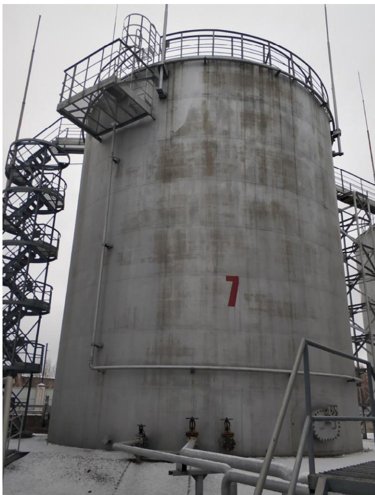
Рисунок 1 - Общий вид резервуара РВСП-1000
