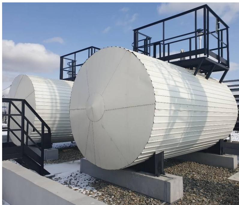
Рисунок 1 - Общий вид резервуаров РГСН-20 (зав. №№ 158-1, 158-2)
