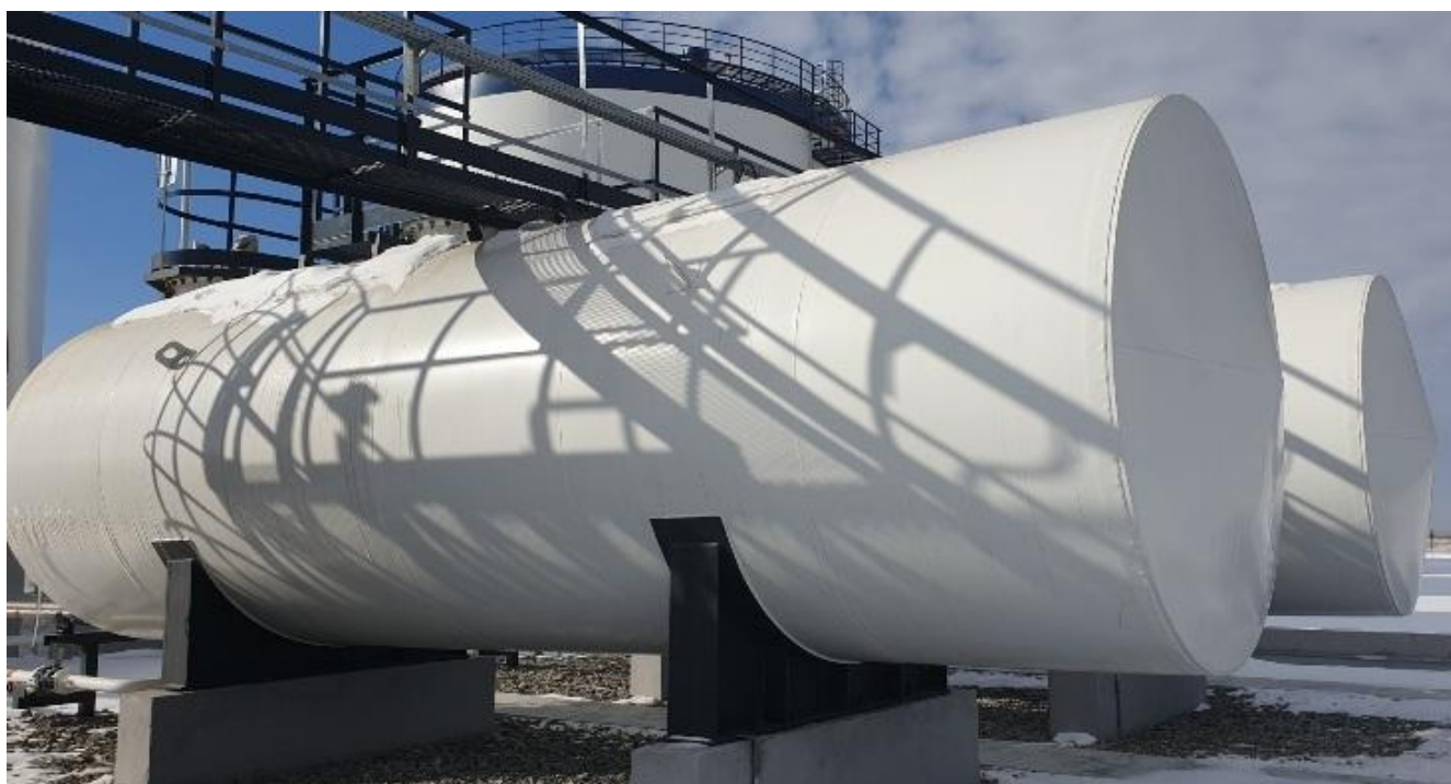
Рисунок 3 - Общий вид резервуаров РГСН-50 (зав. №№ 157-1, 157-2)
