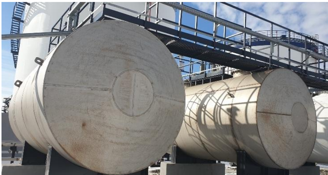
Рисунок 2 - Общий вид резервуаров РГСН-30 (зав. №№ 160-1, 160-2)
