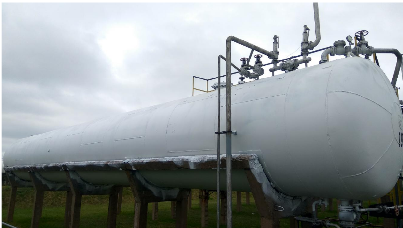
Рисунок 1 - Общий вид резервуара стального горизонтального цилиндрического РГС-175
