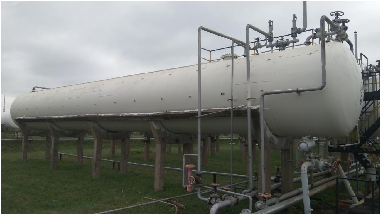
Рисунок 1 - Общий вид резервуара стального горизонтального цилиндрического РГС-175
