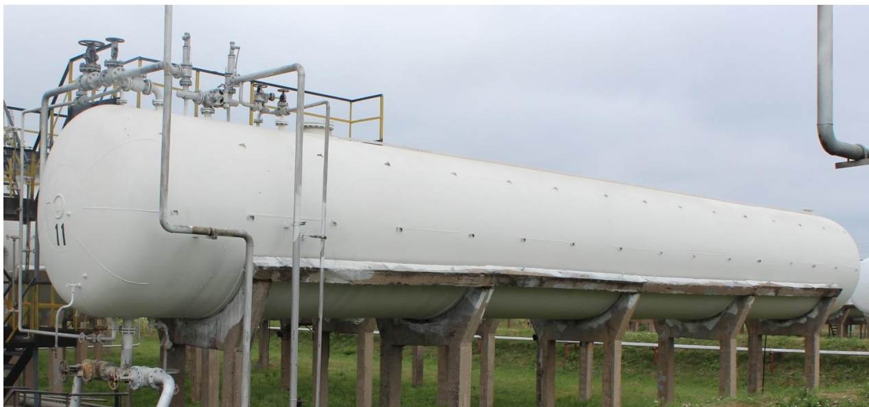
Рисунок 1 - Общий вид резервуара стального горизонтального цилиндрического РГС-175
