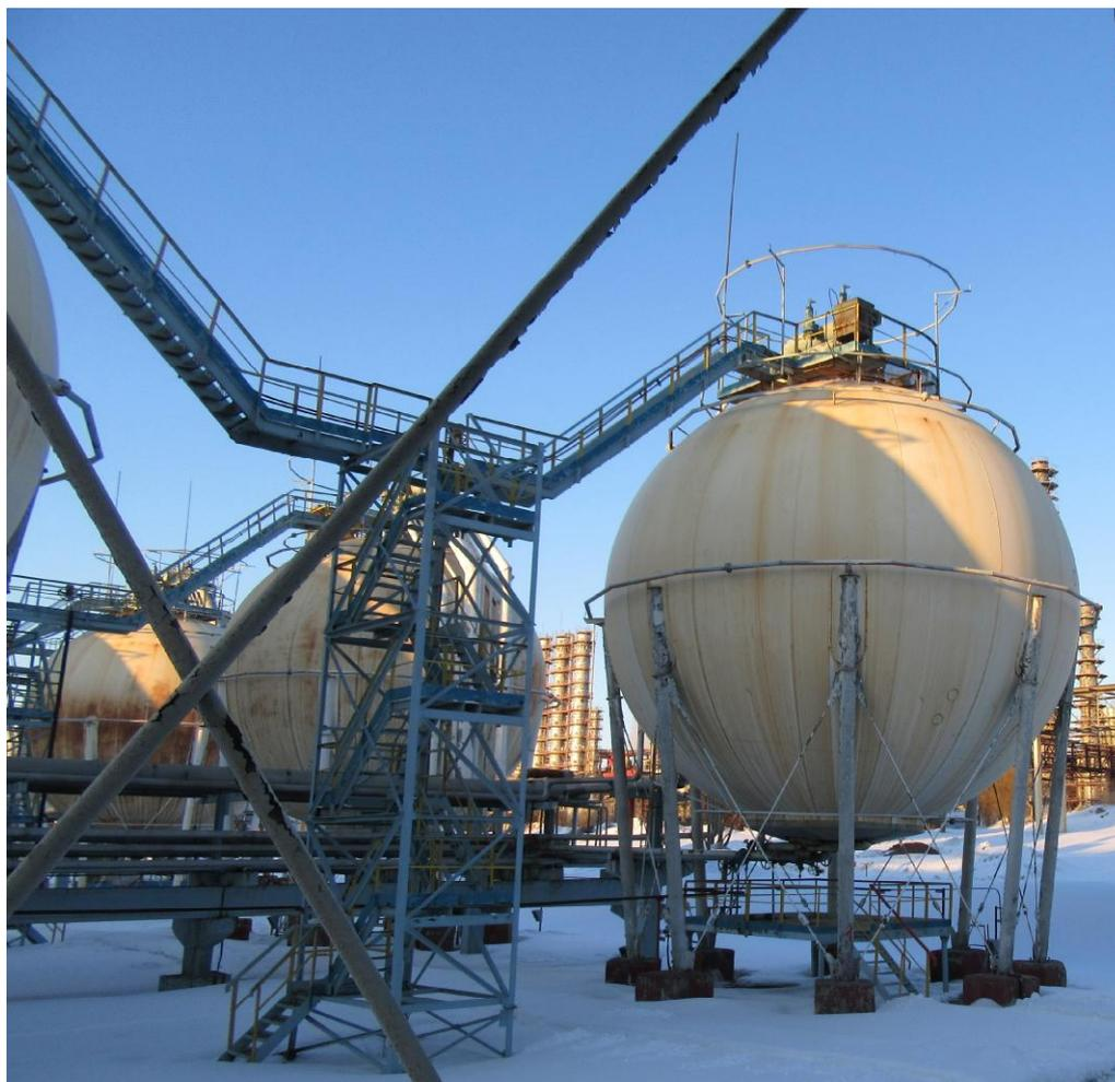
Рисунок 1 - Общий вид резервуара РШС-600
