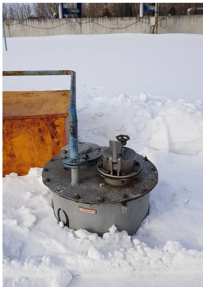
Рисунок 5 - Общий вид видимой части конструкции резервуаров РГС-75 зав. №№ 9, 15
