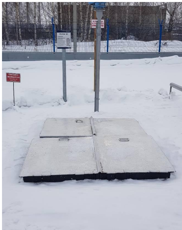
Рисунок 3 - Общий вид видимой части конструкции резервуаров РГСД-50 зав. №95 (слева), РГСД-75 зав. № 38 (справа)
