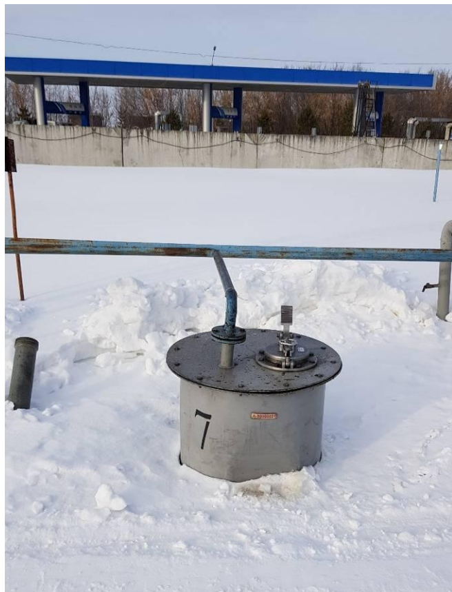
Рисунок 4 - Общий вид видимой части конструкции резервуаров РГС-75 зав. №№ 7, 8
