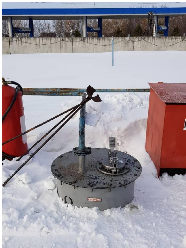
Рисунок 4 - Общий вид видимой части конструкции резервуаров РГС-75 зав. №№ 7, 8
