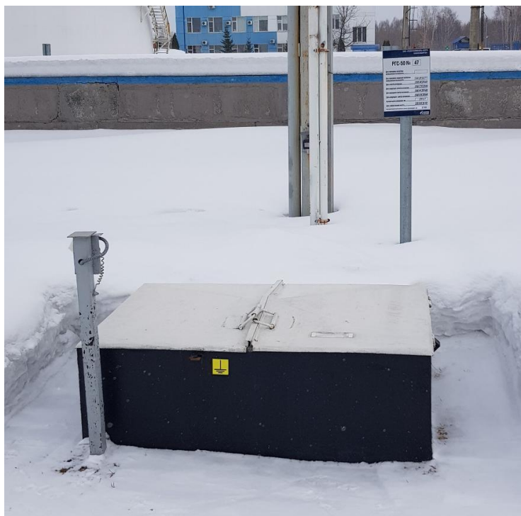
Рисунок 2 - Общий вид видимой части конструкции резервуара РГСД-50 зав. № 126
