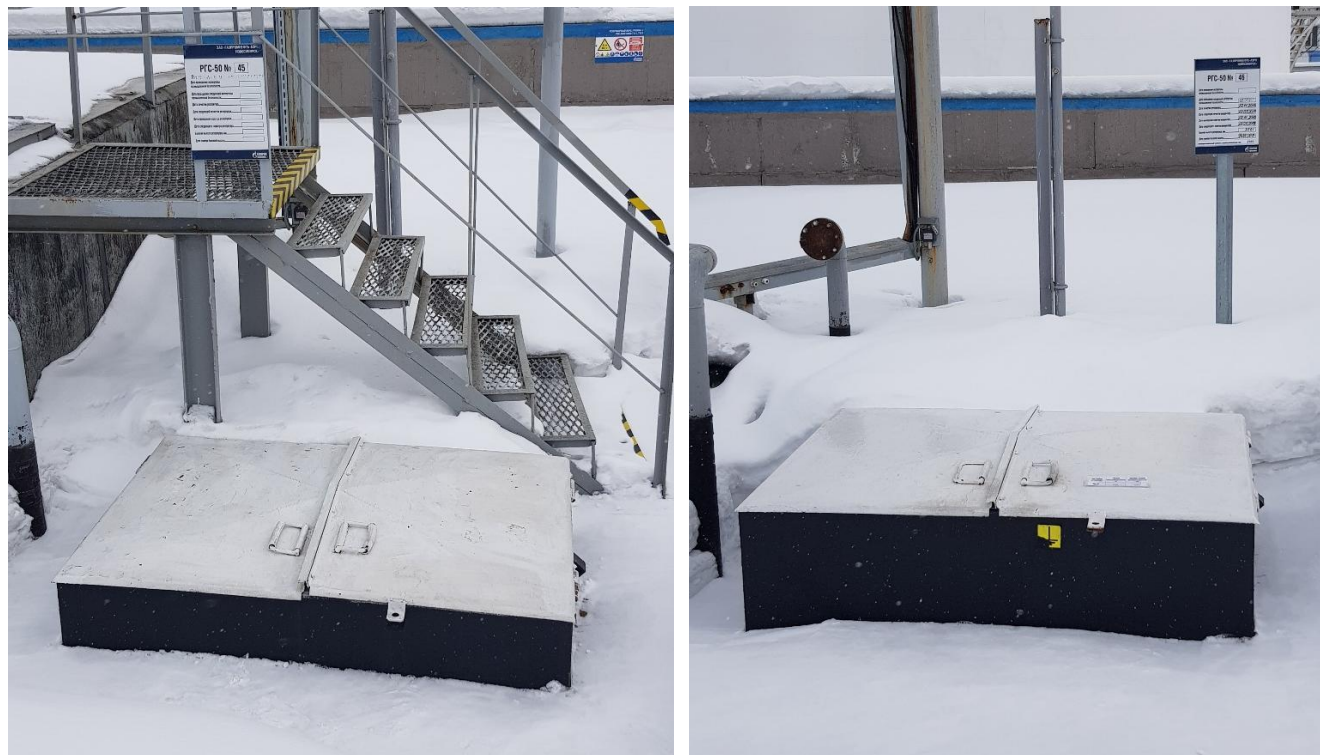
Рисунок 1 - Общий вид видимой части конструкции резервуаров РГСД-50 зав. №№ 124, 125
