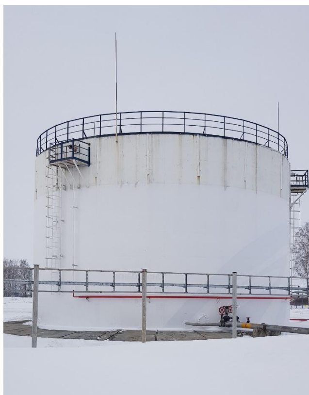
Рисунок 2 - Общий вид резервуаров РВС-3000 №№ 7, 8
