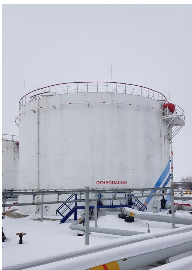
Рисунок 4 - Общий вид резервуаров РВС-3000 №№ Т1-3, Т1-4
