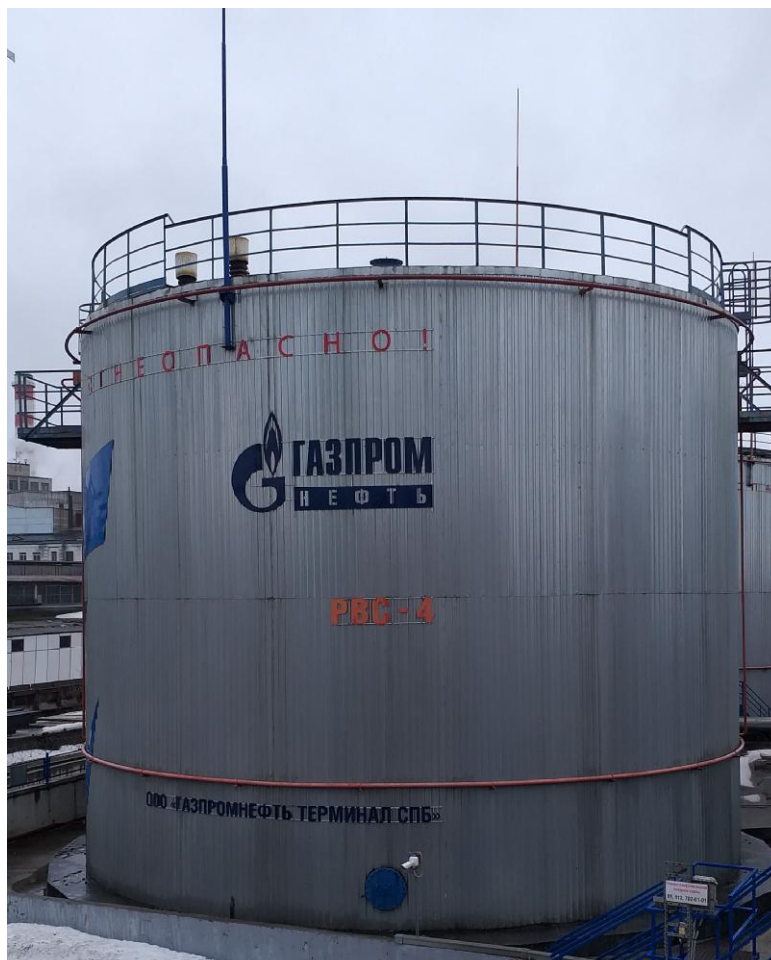
Рисунок 1 - Общий вид резервуара стального вертикального цилиндрического РВС-2000
