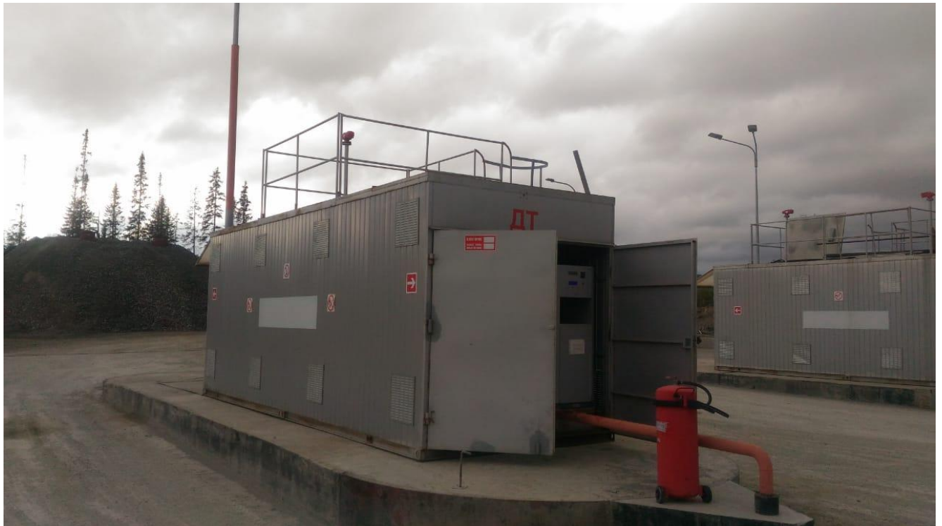
Рисунок 1 - Общий вид резервуара РГС-20
