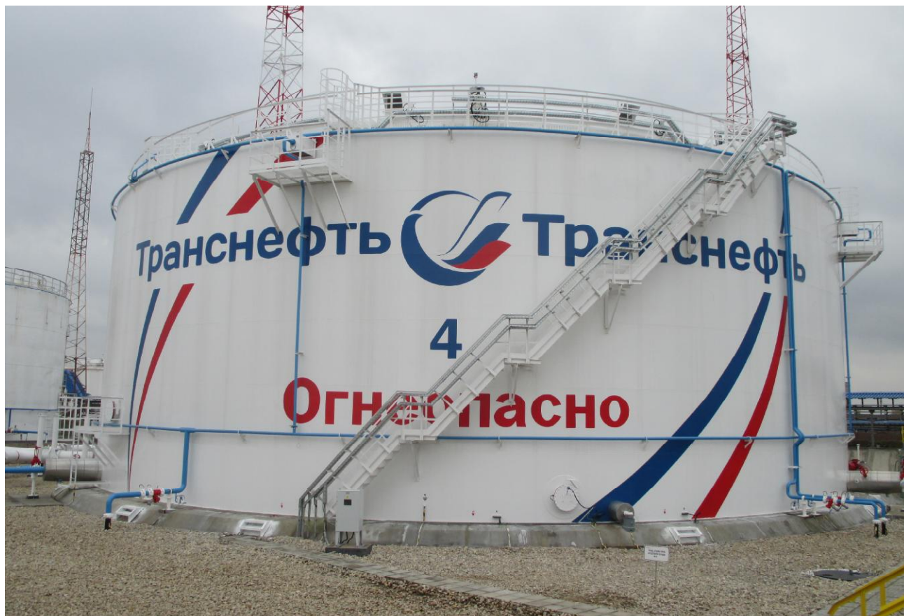
Рисунок 1 - Общий вид резервуара РВСП-10000
