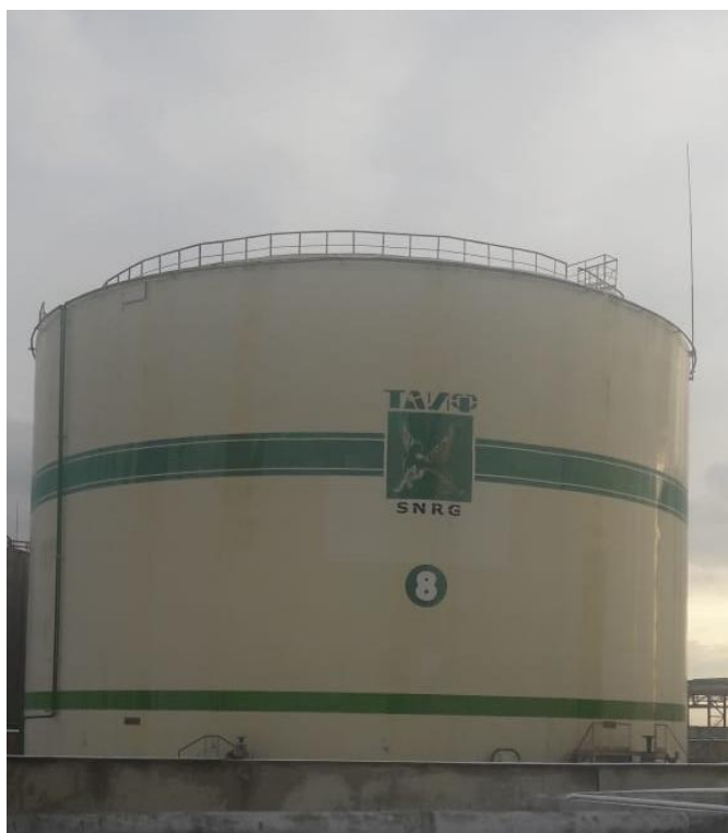
Рисунок 2 - Общий вид резервуара вертикального стального цилиндрического РВС-10000 зав. № 8
