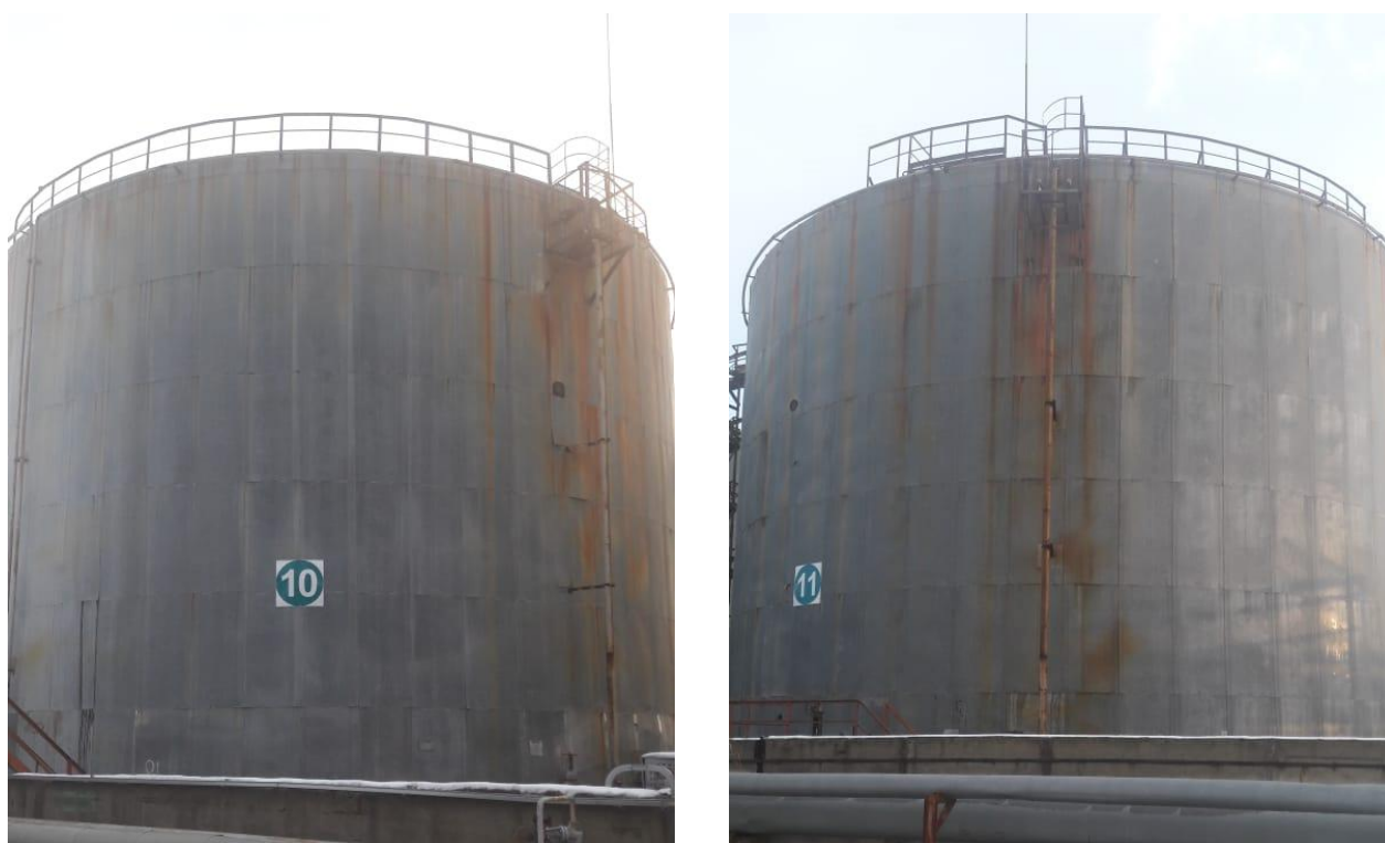
Рисунок 1 - Общий вид резервуаров вертикальных стальных цилиндрических РВС-5000 зав. №№ 10, 11
