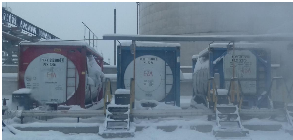
Рисунок 1 - Общий вид резервуара стального горизонтального цилиндрического РГС-23
