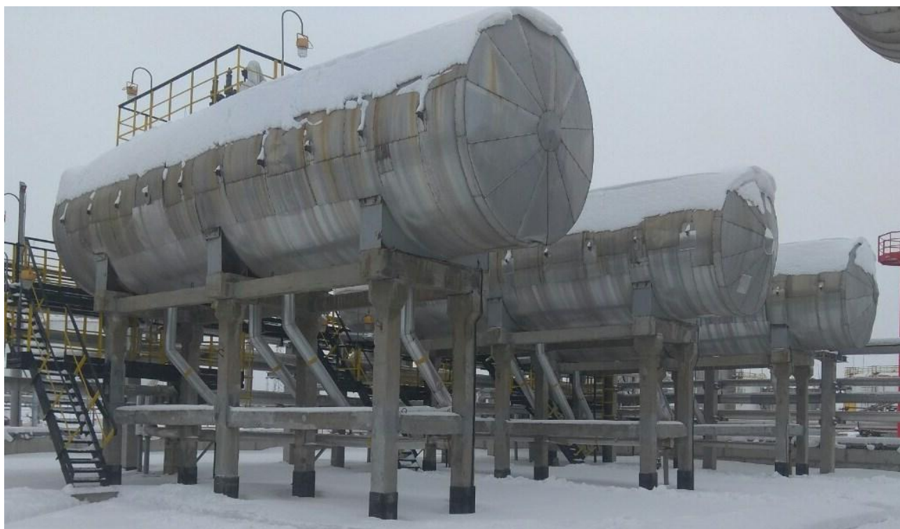
Рисунок 1 - Общий вид резервуара стального горизонтального цилиндрического РГС-100
