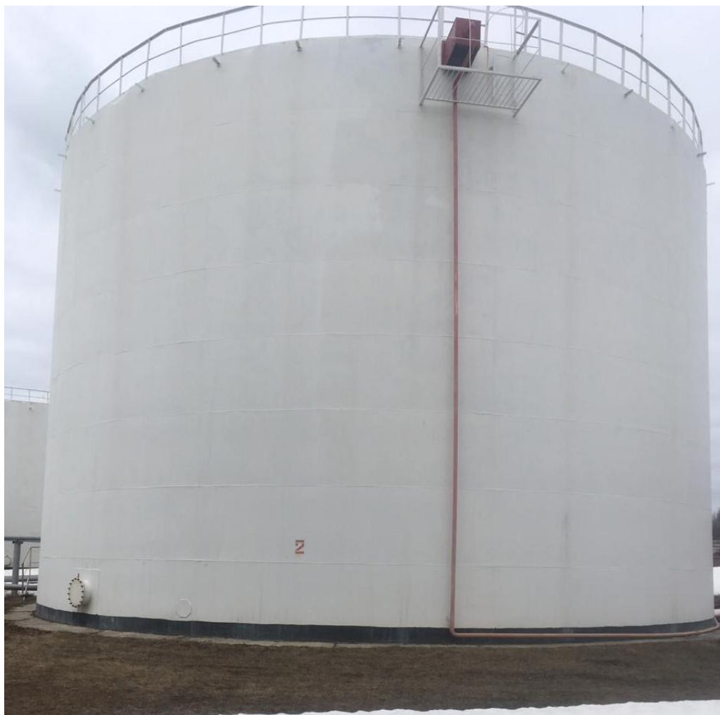
Рисунок 1 - Общий вид резервуара РВС-3000
