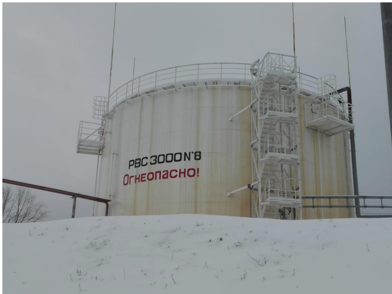
Рисунок 2 - Общий вид резервуара РВС-3000
