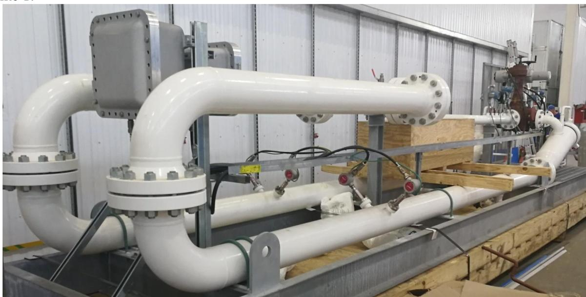
Рисунок 1 – Общий вид установок трубопоршневых двунаправленных ТПУ СГА
