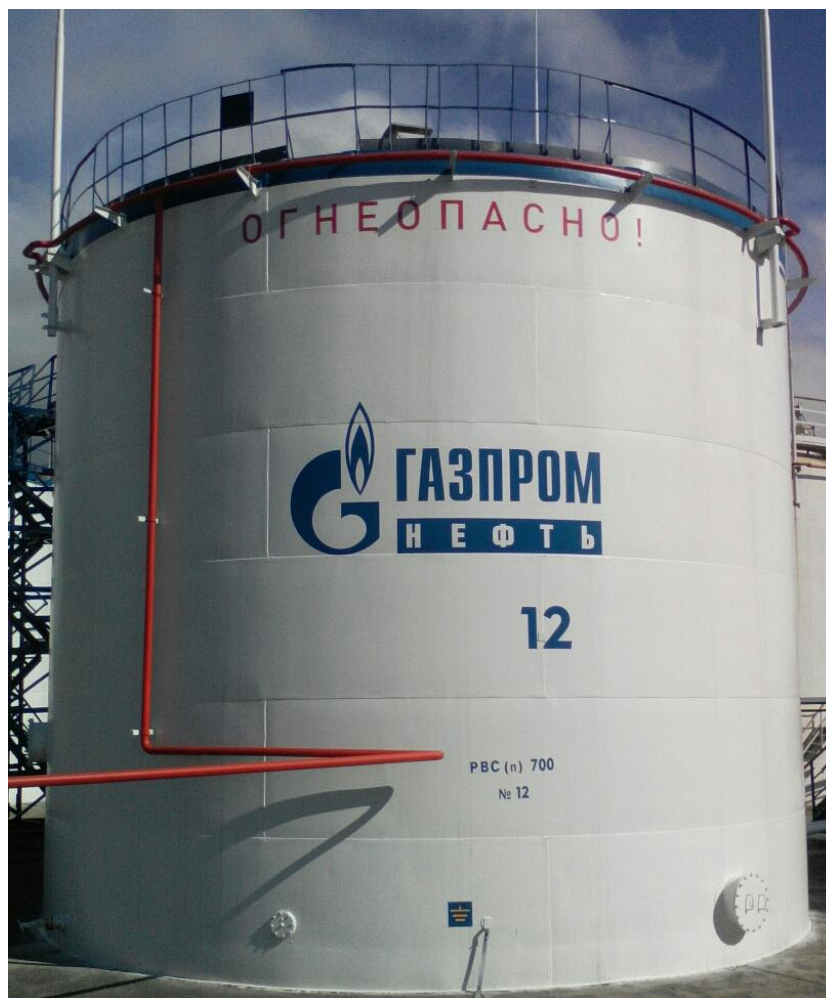
Рисунок 1 - Общий вид резервуаров вертикальных стальных с понтоном РВС(п)-700
