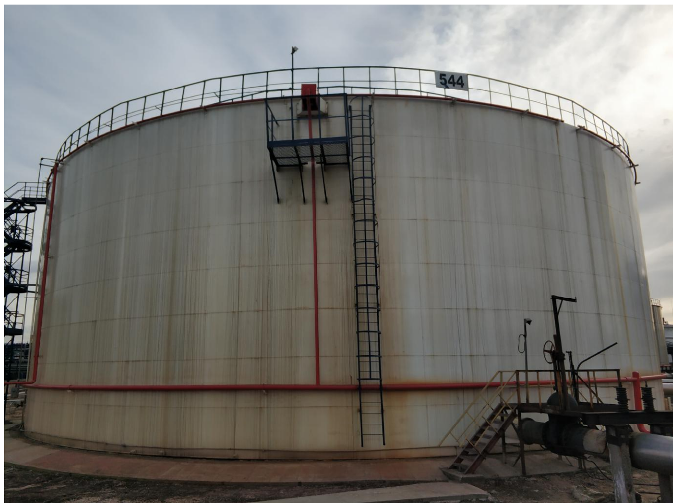
Рисунок 1 - Общий вид резервуара РВС-10000
