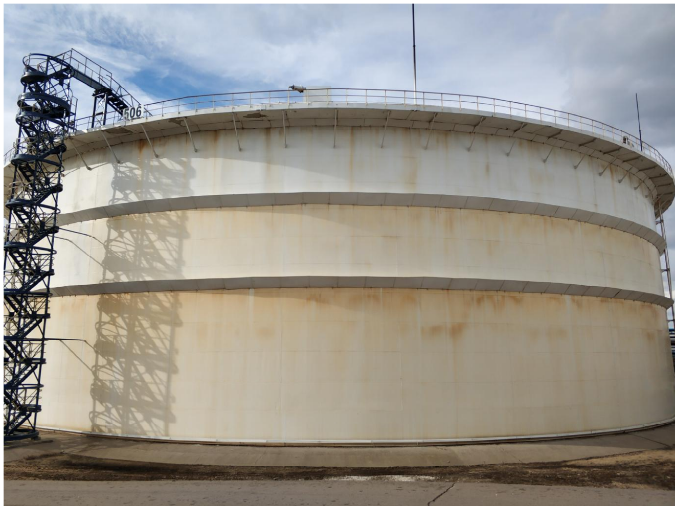
Рисунок 1 - Общий вид резервуара РВСПК-50000
