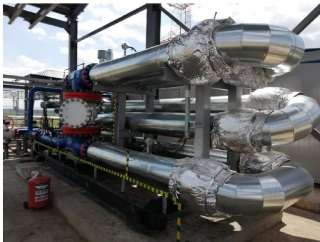
Рисунок 1 – Общий вид установок трубопоршневых «НАФТА-ПРУВЕР»-300
