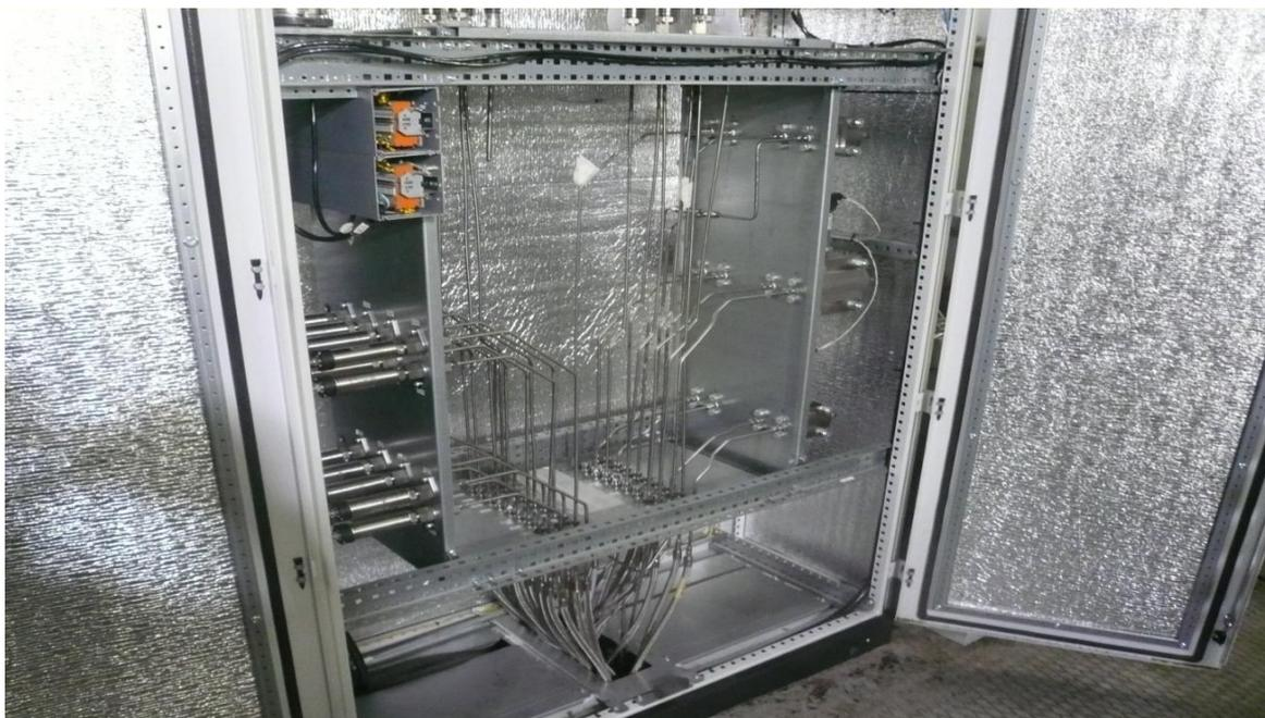
Рисунок 1 - Шкаф измерительных преобразователей
