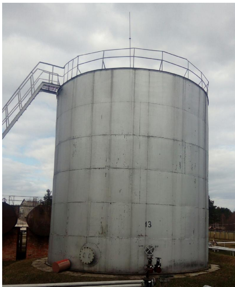
Рисунок 1 - Общий вид резервуара стального вертикального цилиндрического РВС-400
