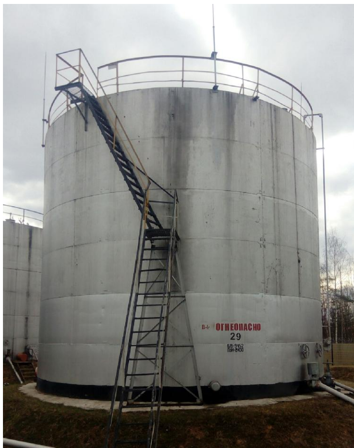
Рисунок 2 - Общий вид резервуара стального вертикального цилиндрического РВС-700, РВСП-700
