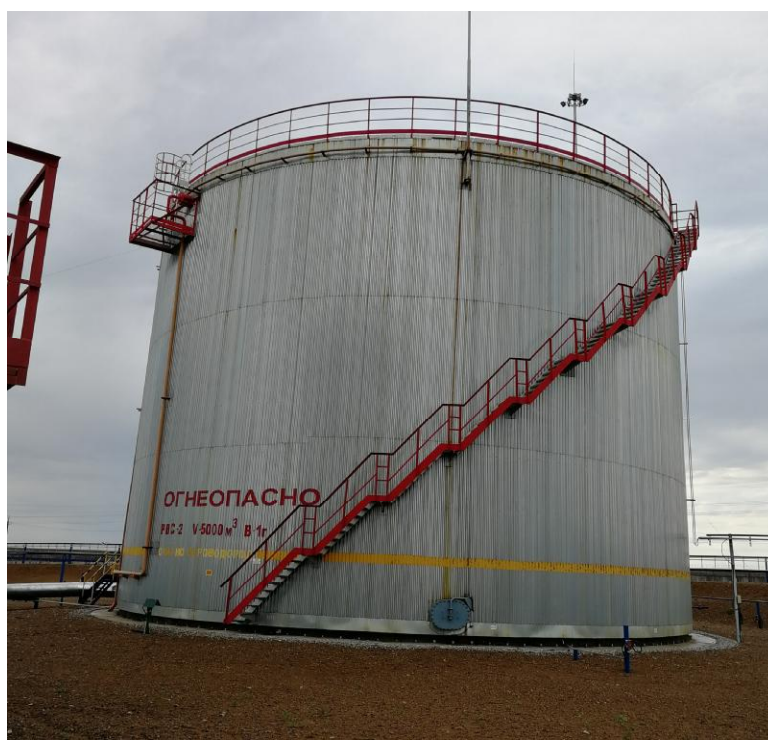
Рисунок 1 - Общий вид резервуара стального вертикального цилиндрического с понтоном РВСП-5000
