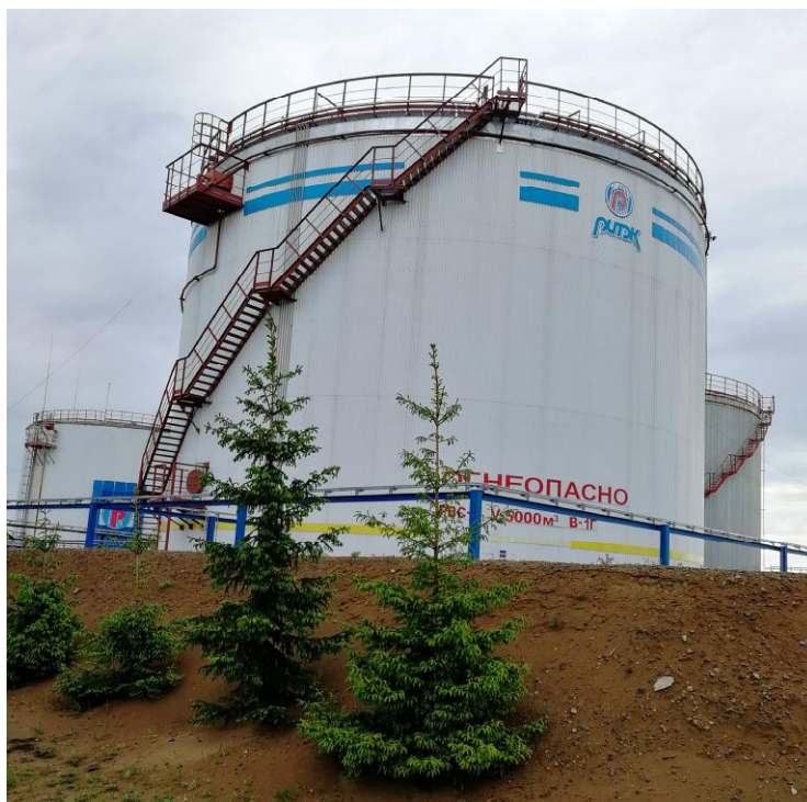
Рисунок 1 - Общий вид резервуара стального вертикального цилиндрического с понтоном РВСП-5000
